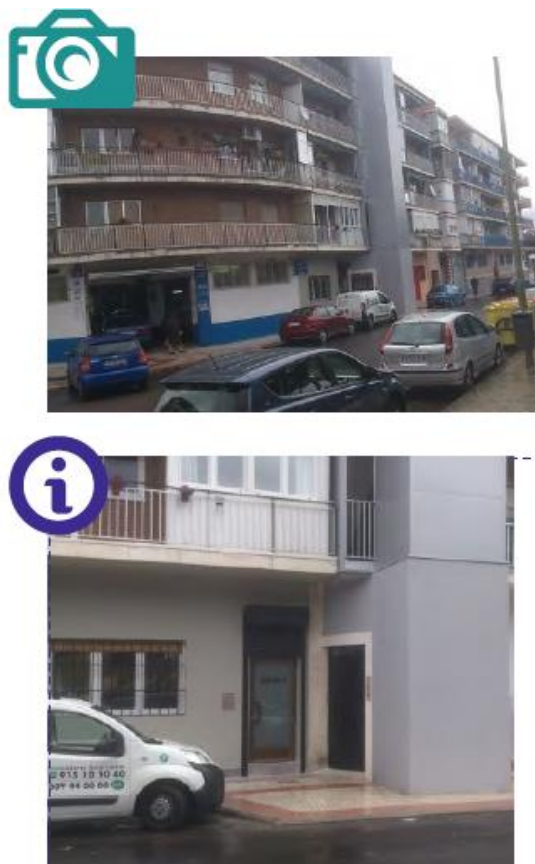
Imagen 40: Ejemplos de actuación. Instalación de ascensor con ocupación de vía pública.
