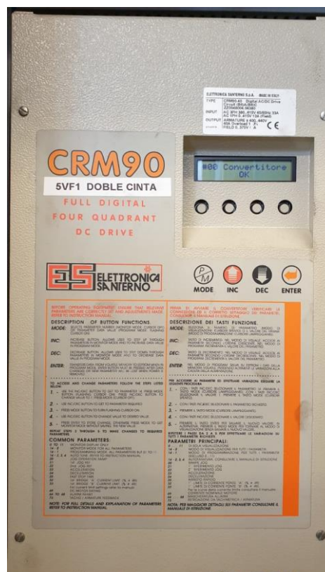
Ilustración 21 Variador de frecuencia reutilizado SANTERNO “fuente: web Santerno”
