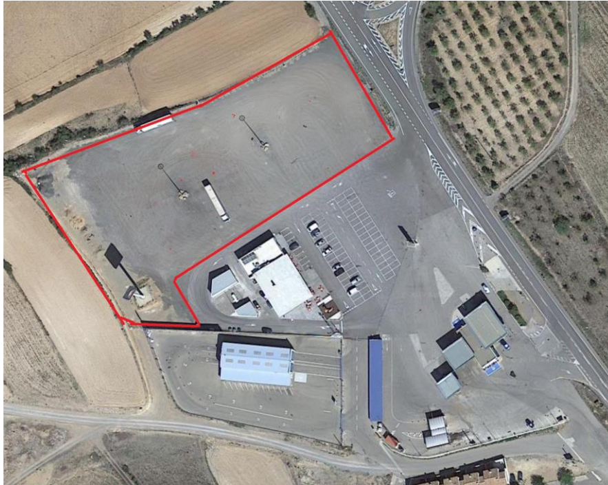
Fig. Delimitación de la zona a asfaltar
