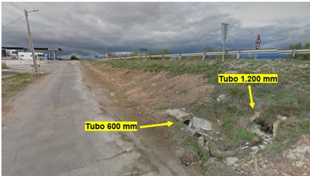
Fig. Salida del colector a la obra de drenaje transversal de la carretera.
