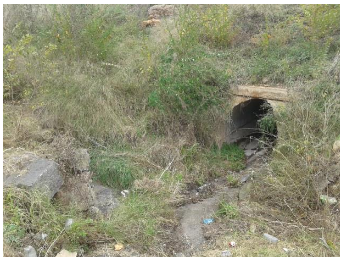
Fig. Desagüe del colector en embocadura de ODT tipo caño
