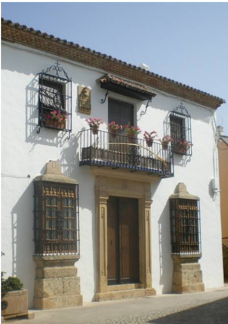
Fig. 1: Estructura muraria. Ronda. Málaga.
