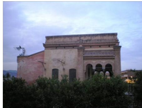
Fig. 39: Fachada Sur del "Maset dels Artola" en el camí Lledó.
