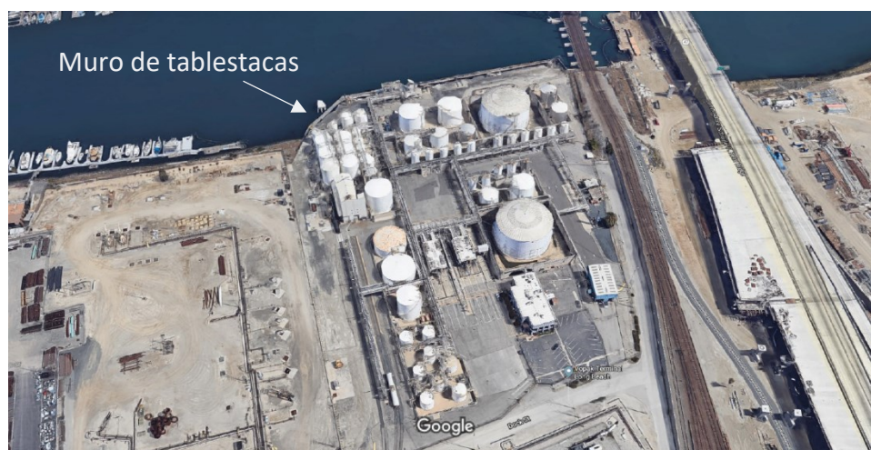
Figura 131 - Localización del muro de tablestacas en la segunda zona crítica (Google, 2019)
