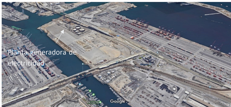
Figura 132 - Localización de la planta generadora de electricidad en la segunda zona crítica (Google, 2019)
