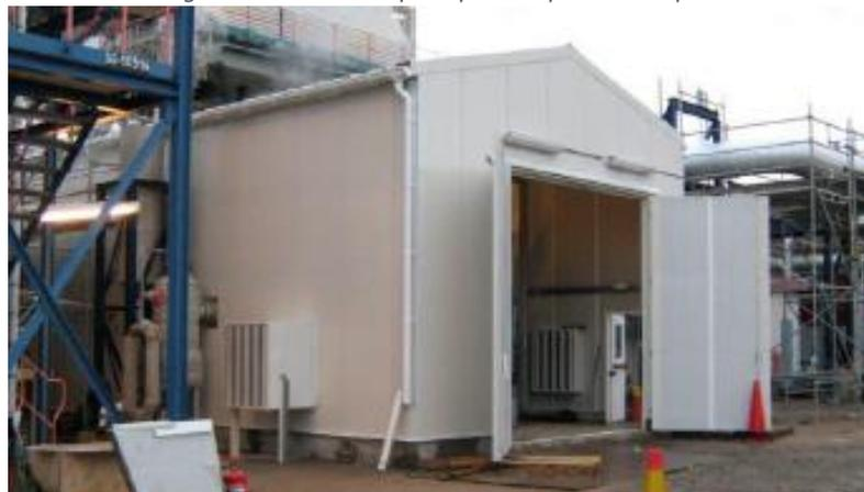
Figure 50. Exemple de réalisation de capot acoustique
