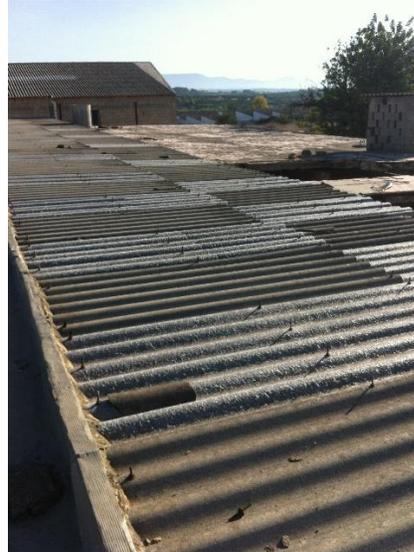
Demolición de la parte de cubierta perteneciente a la nave 2, en la cual las viguetas pretensadas se encuentran fuertemente afectada por aluminosis, todo el tramo afectado será remplazado por un nuevo forjado. También se ejecutarán nuevas pendientes con mortero aligerado.
