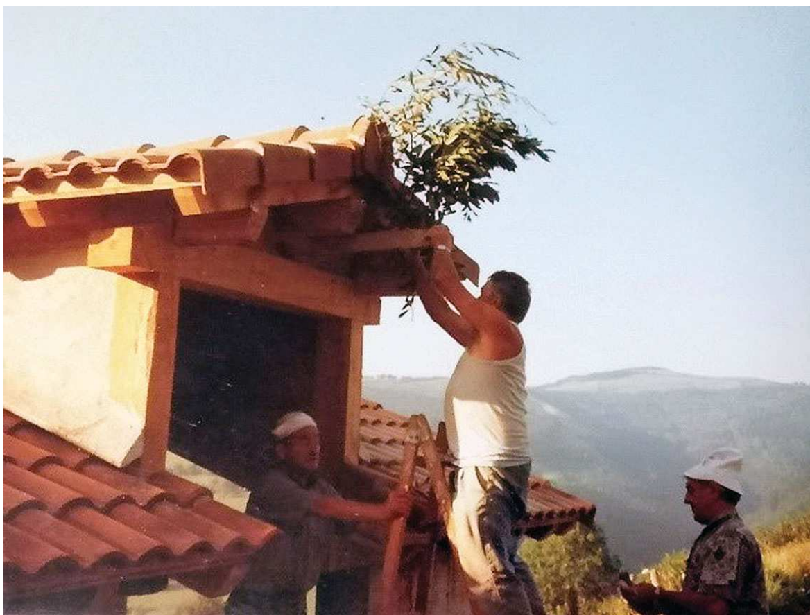
Ilustración 79. Colocación de una sagatza al terminar la cubierta. Caserío Sagatzeta. Errezil (Guipuzcoa). Fuente: Propia
