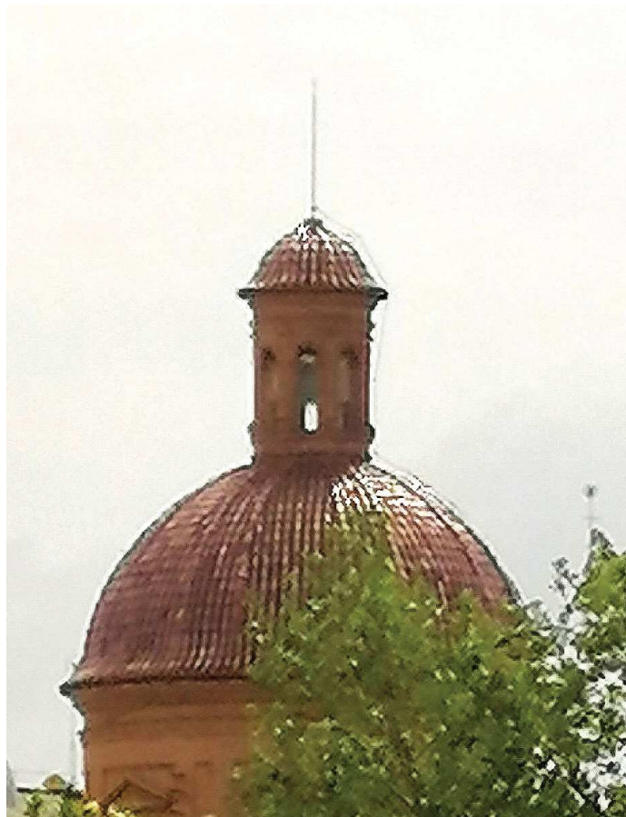
Ilustración 84. Cúpula con tejas con reflejo metálico. Cúpula de Santo Domingo. Valencia. Fuente: Propia.
