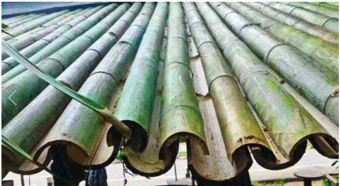
Ilustración 24. Cubierta con bambú en media caña. Fuente: https://bambu.gruil.com
