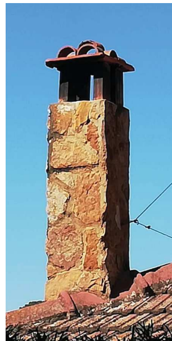
Ilustración 18. Chimenea con sombrero de tejas curvas cerámicas en el Vedat. Torrente. Valencia. Fuente: Propia.
