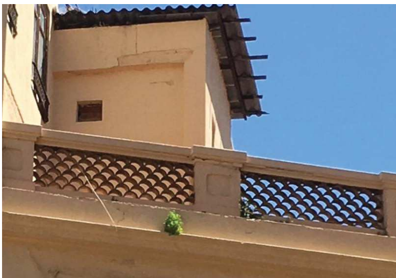
Ilustración 12. Peto realizado con tejas. Calle Almudín esquina Plaza de San Luis Esteban. Fuente: Propia
