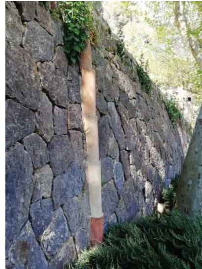
Ilustración 6. Cañerías de desagüe. La granja de Esporlas. Mallorca. Fuente Propia.
