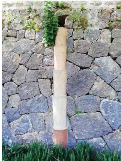
Ilustración 6. Cañerías de desagüe. La granja de Esporlas. Mallorca. Fuente Propia.
