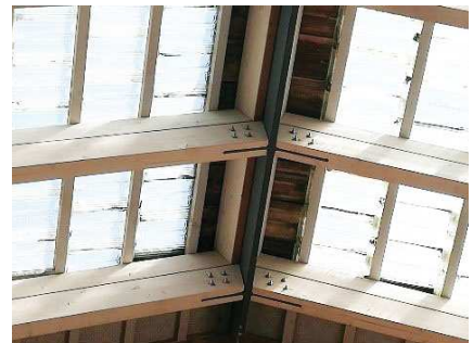
Ilustración 36. Teja translúcida de reposición. Entrada a Bombas Gens. Fuente: Propia
