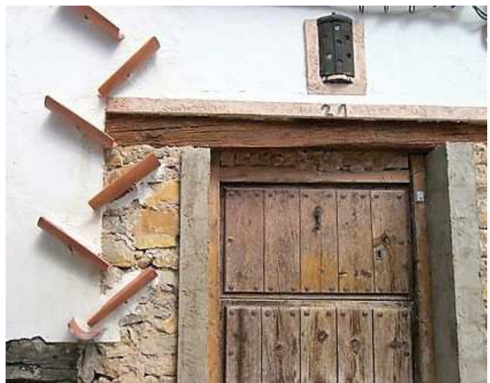
Ilustración 10. Canaleta de desagüe en fachada. Monteverde. Albarracín. Fuente: https://reinventos.wordpress.com
