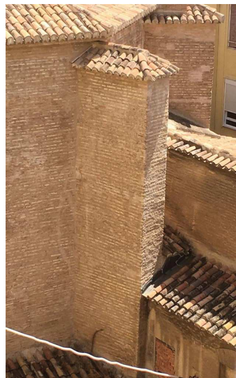
Ilustración 15. Tejadillo de remate de contrafuerte. Iglesia de san Juan de la Cruz. Valencia. Fuente: Propia.
