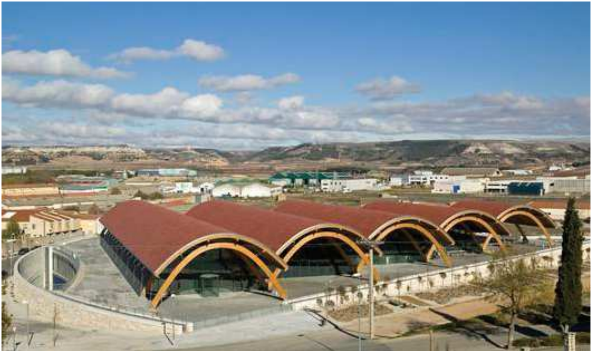
Ilustración 100. Bodegas Protos, Peñafiel (Valladolid). Richard Rodgers, Alonso y Balaguer. Año 2008 . Fuente: https://archdaily.com/500502/bodegas-protos-richard-rogers-alonso-y-balaguer
