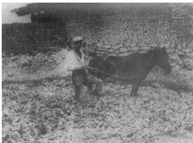
Ilustración 46. Amasado del barro. Fuente: Oficios tradicionales. https://Guipuzcoa.eus
