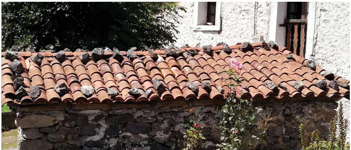
Ilustración 67. Cubierta con piedras en su perímetro. Caserio Altzarte, Azpeitia, Guipúzcoa. Fuente Propia.
