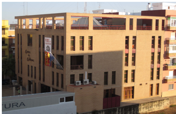
Fotografía edificio biblioteca pública municipal de Puzol.
