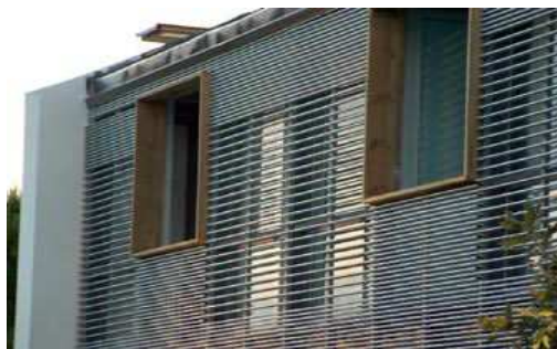
Fotografía de ventanales con instalación de lamas.
