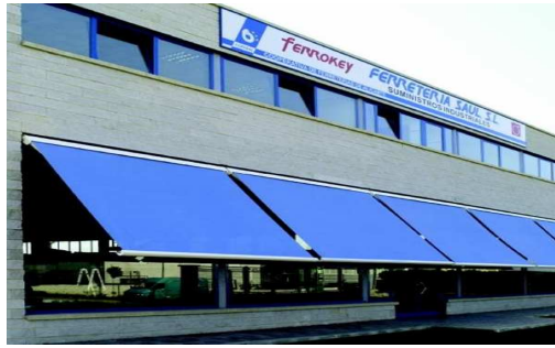
Fotografía de ventanales con instalación de toldos.
