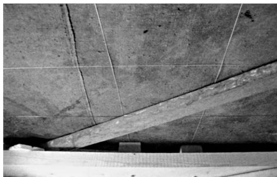
Fig. 3. Reticulo de hilos de poliéster
