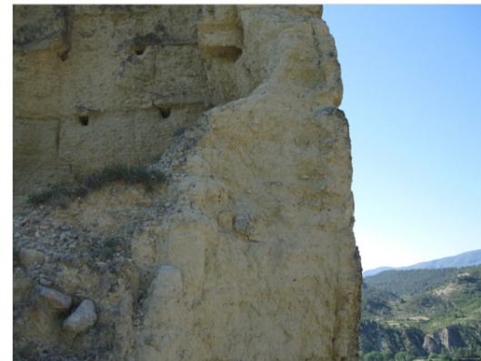
Es una tapia calicostrada. El calicostrado le aporta mucha resistencia a las paredes, pero una vez que se deteriora esta costra, la fabrica pierde resistencia.
