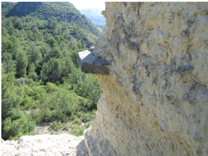
Fig. 3.27. Mampuestos en esquina para aumentar la resistencia de la fabrica.
