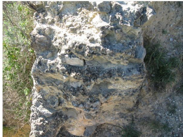
La tapia llega hasta una altura de 2 metros. Esta esta hecha de una mezcla de áridos y cal, formando un mortero.
