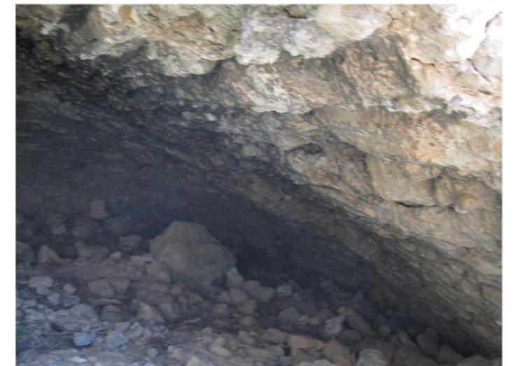
En la cimentación se usaba mampuestos ordenados, era realizada con piedra recibida con mortero. En esta fotografía podemos apreciar la cimentación de la torre sureste
