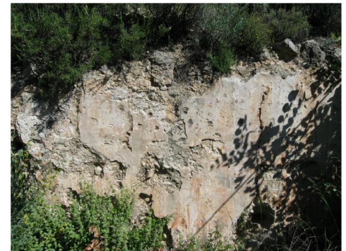
En la cimentación se usaba mampuestos ordenados, era realizada con piedra recibida con mortero. En esta fotografía podemos apreciar una especie de murete a modo de contención de tierras.
