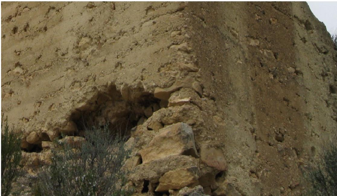
Fig. 3.23. Cimentación castillo de los Murones.<sup>34</sup>
