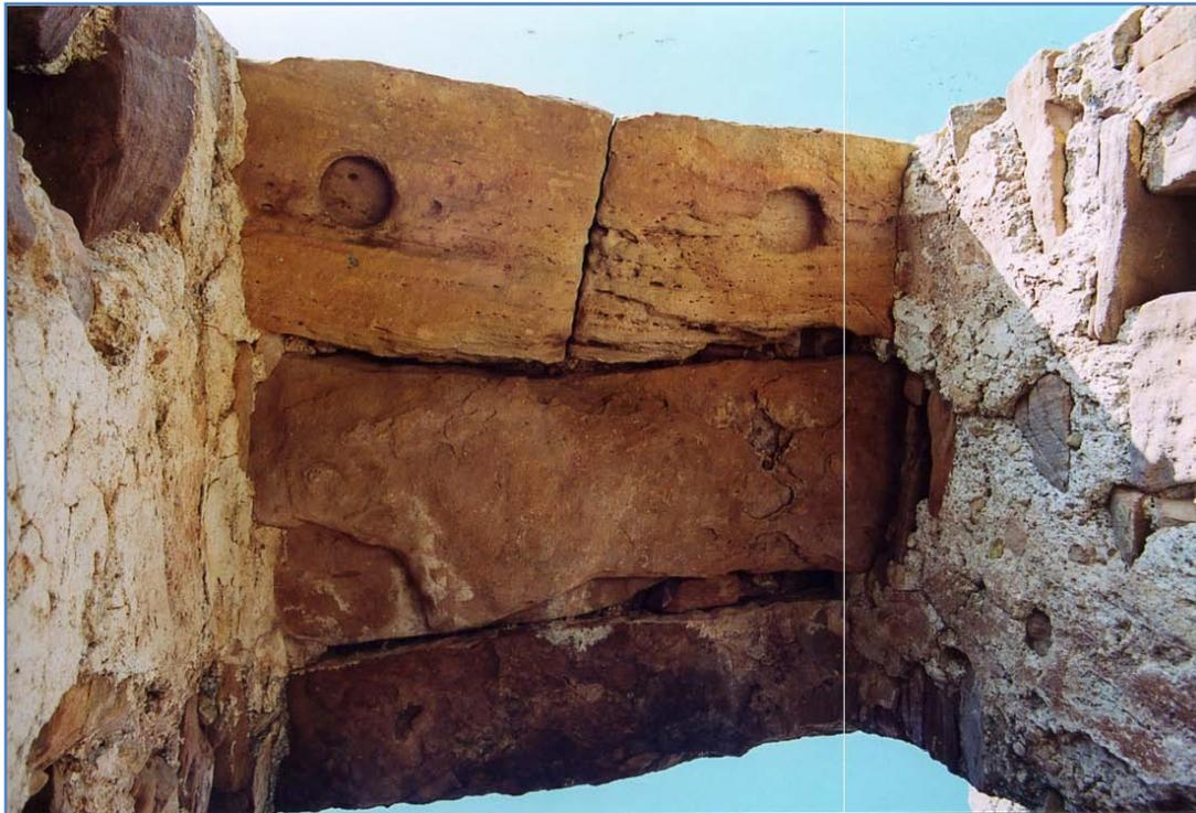
Fig. 3.20. fotografía de los huecos de los goznes de las dos hojas de la puerta de la ermita de Serra<sup>30</sup>
