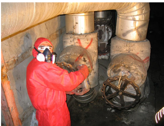
Figura 74. Caldera a retirar
