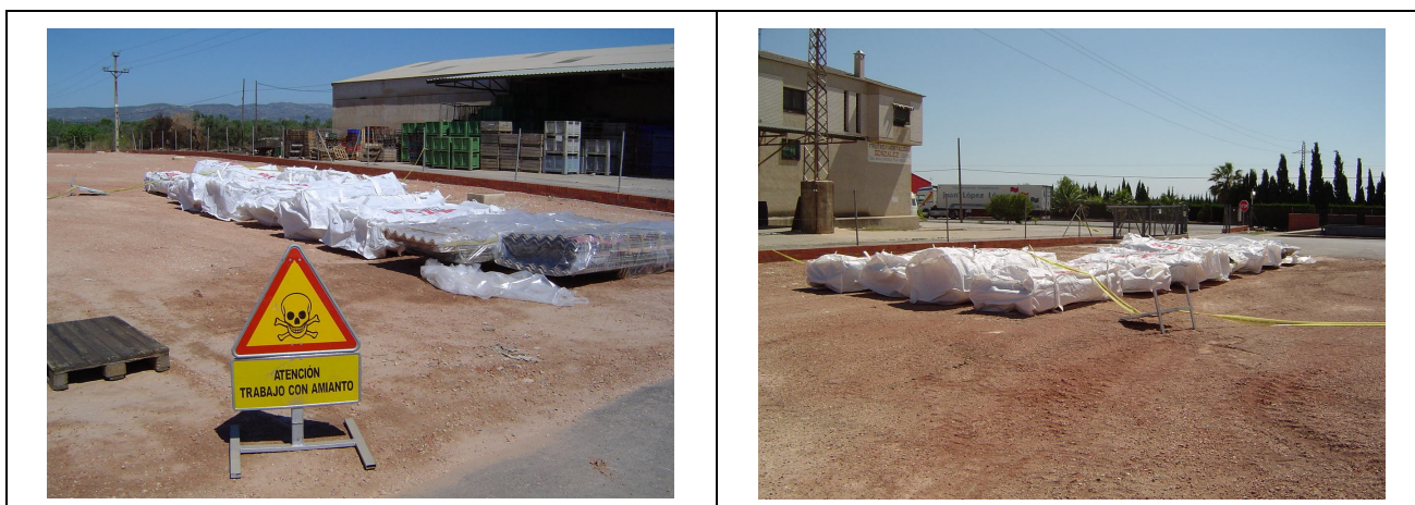
Figura 69. Zona de acopio
