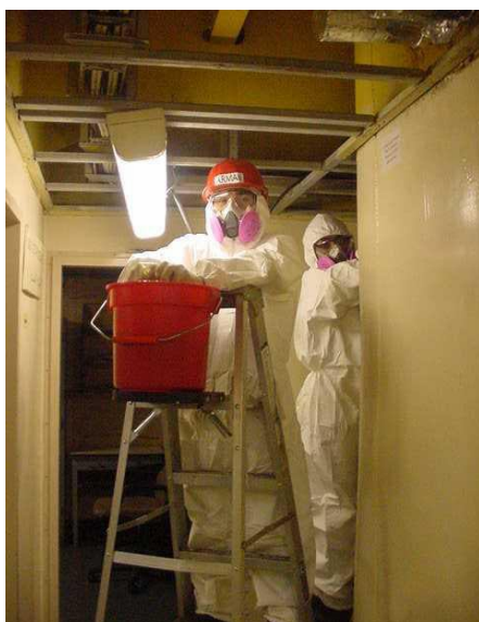
Figura 55. Amianto friable en falsos techos y suelos
