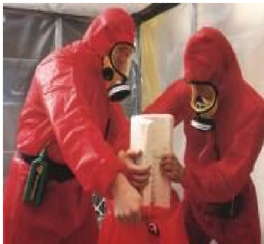
Figura 82. Encapsulamiento en mini-bags
