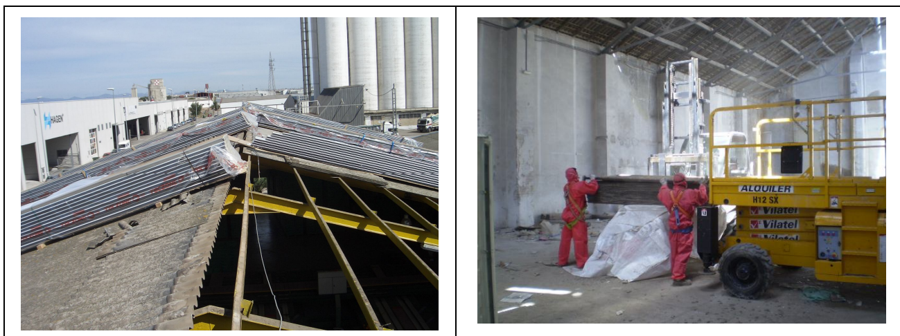
Figura 68. Encapsulamiento de paquetes para su bajada a zona de acopio
