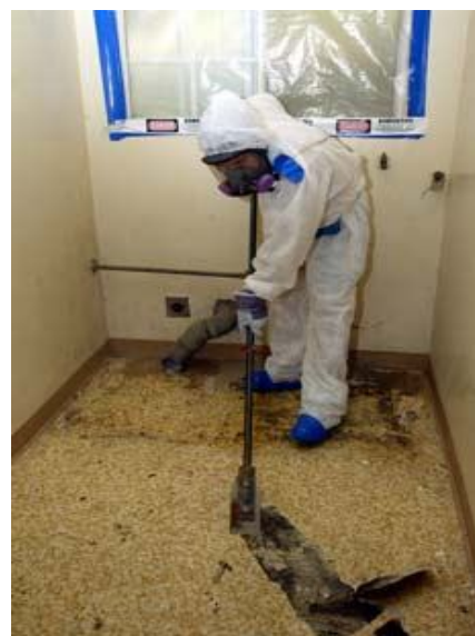
Figura 55. Amianto friable en falsos techos y suelos
