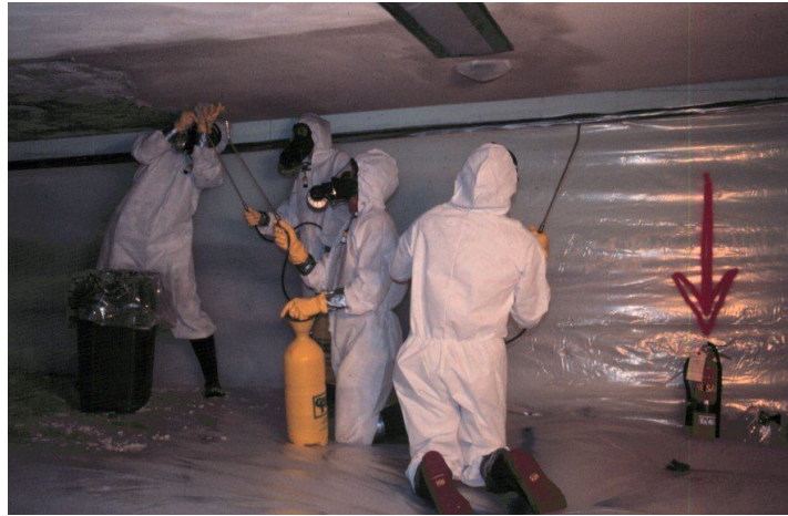
Figura 78. Tareas de humectación
