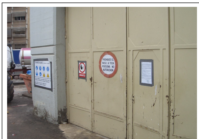
Figura 75. Señalización acceso a obra
