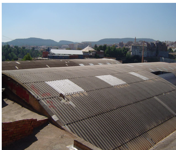
Figura 59. Cubierta a retirar
