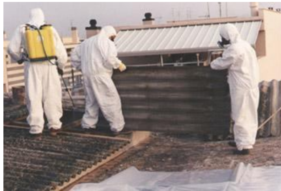
Figura 62. Humectación de la zona de trabajo
