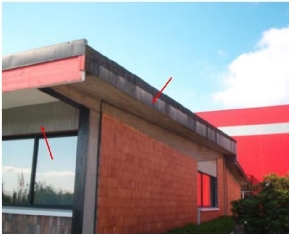
Foto 01: placas de fibrocemento, contienen amianto.
