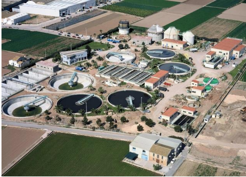
Figura 3.1 Vista aérea de EDARU cuenca del Carraixet [6]
