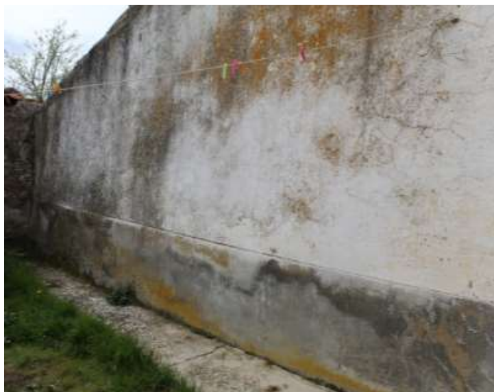
Figura 31. Fachada orientada al Este. Fuente propia.
