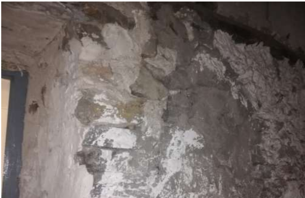
Figura 17. Muro de mampostería. Fuente propia.
