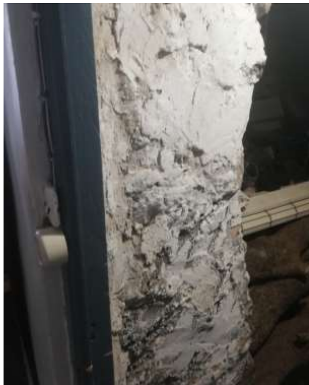
Figura 16. Ancho de muro de mampostería sin revestir. Fuente propia.
