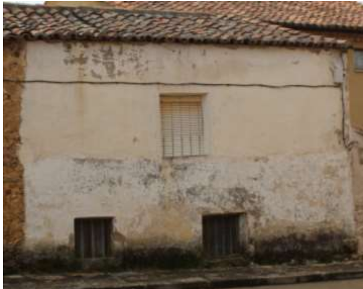
Figura 30. Fachada orientada al Norte. Fuente propia. Fuente propia.
