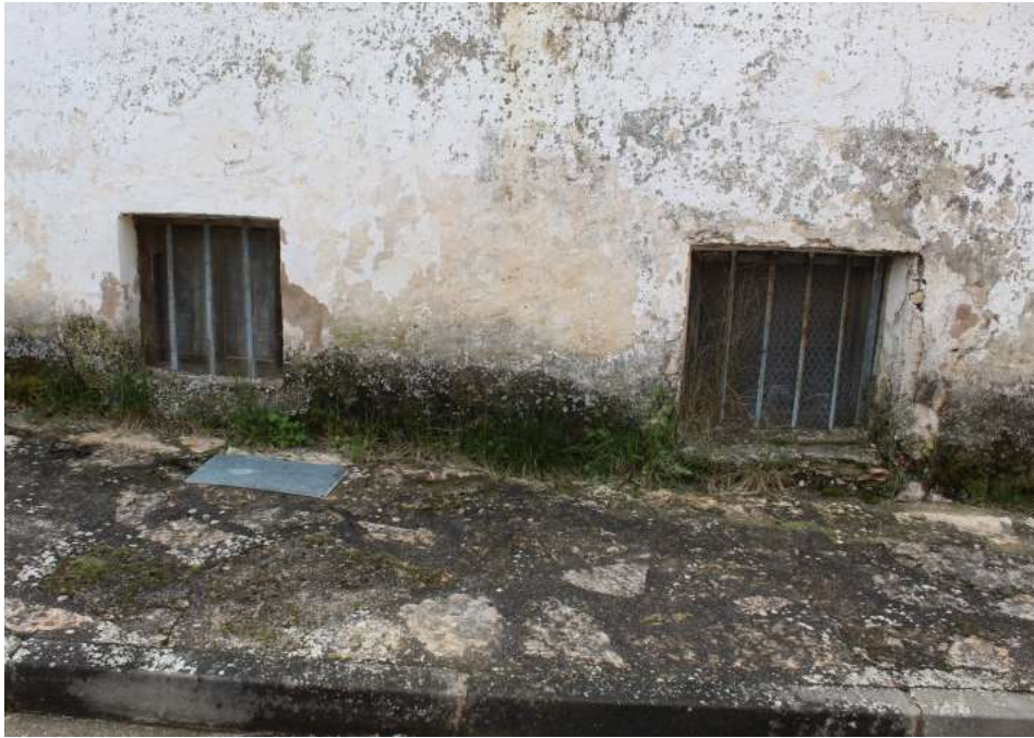
Figura 36. Parte inferior de la fachada Norte. Fuente propia.
