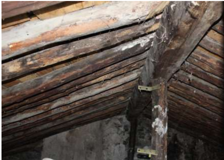
Figura 23. Estructura de la cubierta. Fuente propia.
