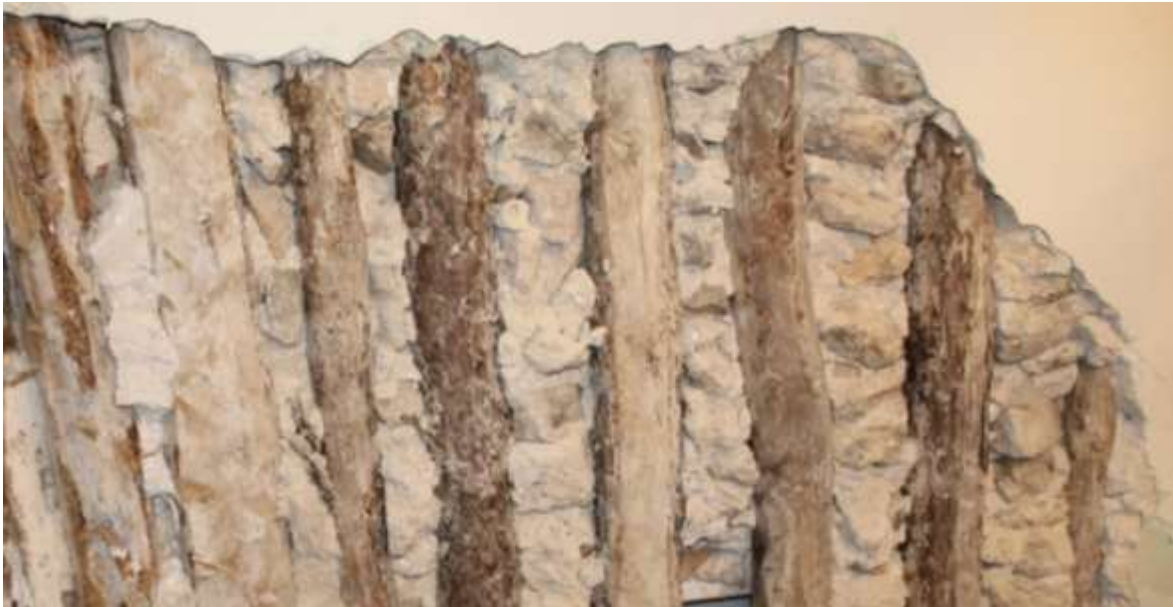
Figura 22. Tabique picado. Fuente propia.
