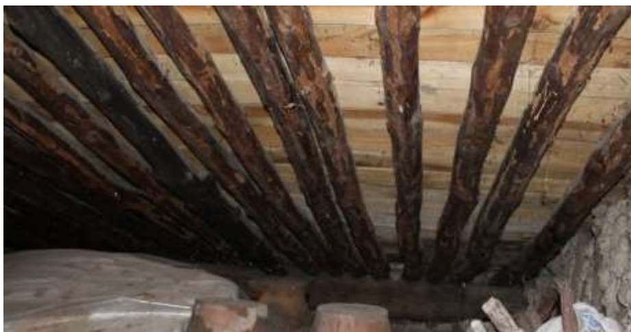
Figura 52. Estructura de la cubierta del espacio bajo cubierta. Fuente propia.
