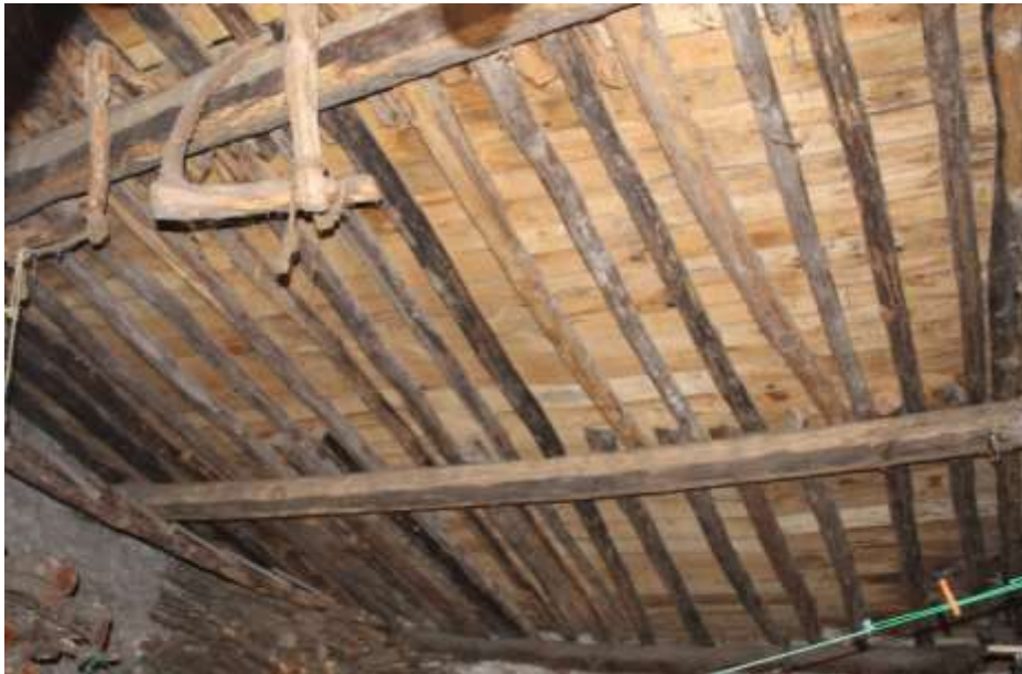
Figura 51. Estructura de la cubierta de la cuadra. Fuente propia.
