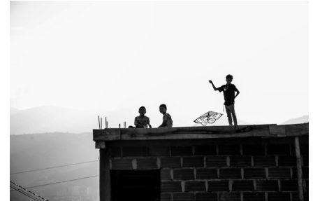
2.2.1.25. Foto Niño con cometa sobre el planchón de una vivienda en construcción en El Faro, año 2018. Fuente: Archivo Techo-Medellín.
