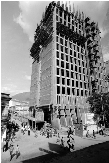
1.1.3.7. Edificio Coltejer en construcción (1968-1972). Fuente: Fotografía de Gabriel Carvajal. Archivo Fotográfico BPP.
