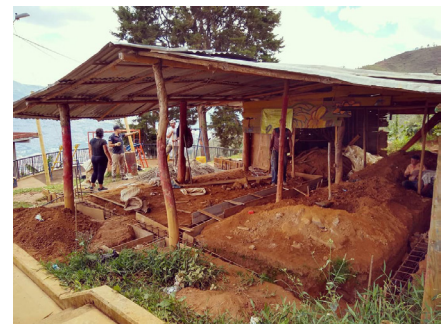
2.3.1.16. Foto Hormigonado de las vigas riostras, convite comunitario. El Faro, 2019. Fuente: Instagram @coonvite.
