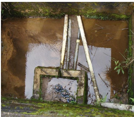
2.2.1.31-32. Foto superior Tanque distribuidor de agua del acueducto comunitario.
