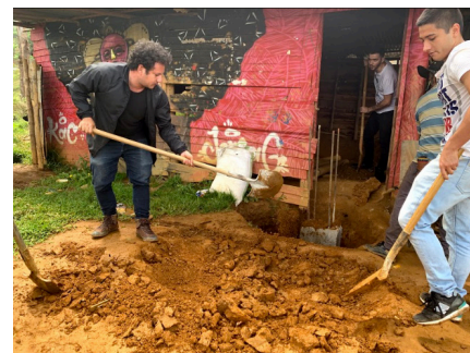
2.1.2.6. Imagen Convite comunitario para la construcción del salón comunal en el barrio El Faro, Medellín, año 2019. Fuente: fotografía propia.
