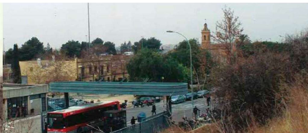
Misma imagen en 1995, desde las vías de Renfe. Estación de EMT primer plano.
