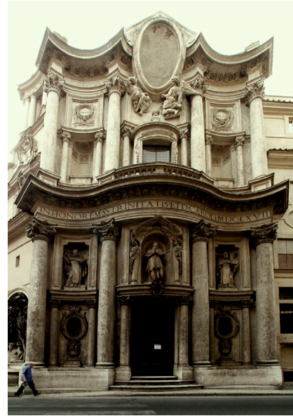
Figura 1.24 - Fachada frontal de la iglesia de San Carlo alle Quattro Fontane, Roma.
