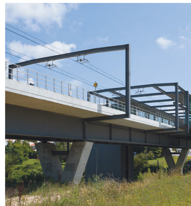
Vista de la estructura de la Estación de Parque Maia
