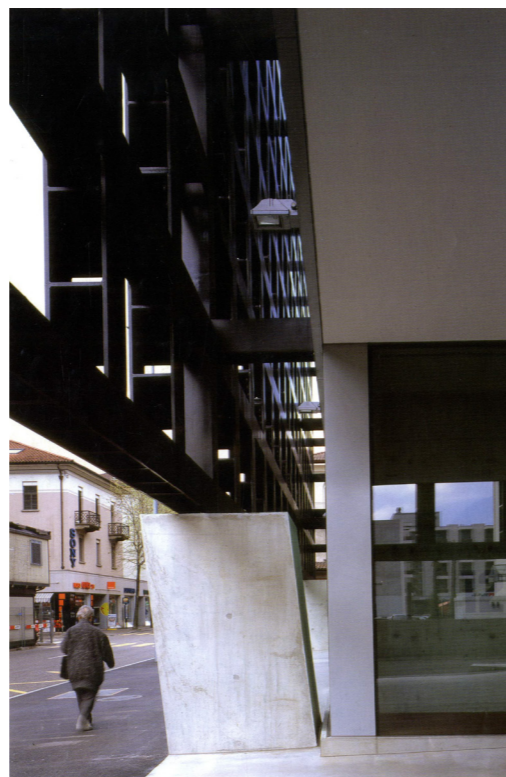
Vista de la estructura de Ferreira de Locarno
