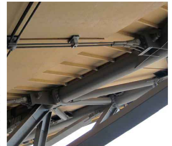
Velódromo Londres. Detalle anillo de compresión.
