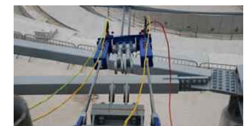
Nudos perimetrales. Cable empotrado.
