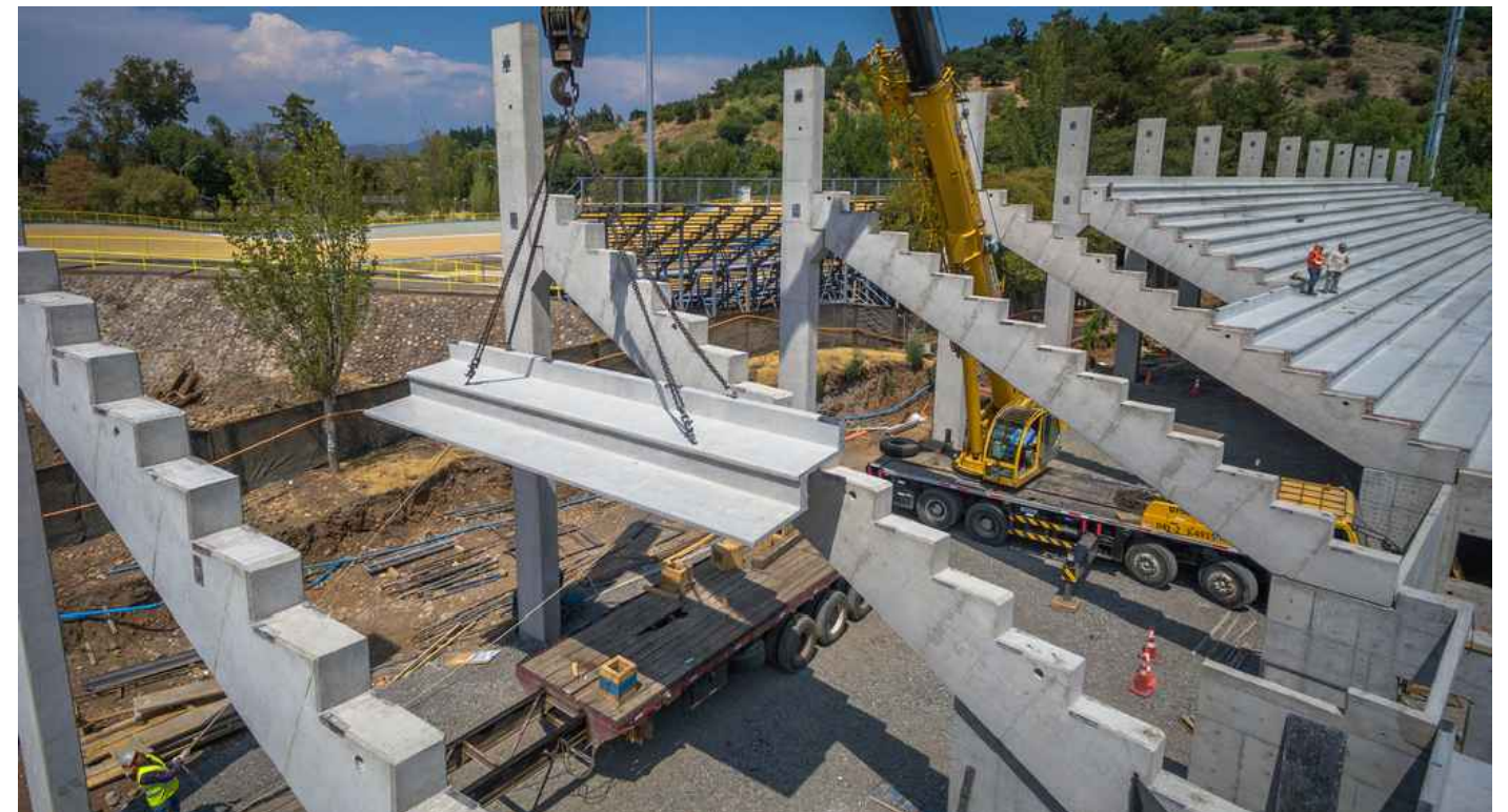
Izado gradas prefabricadas
