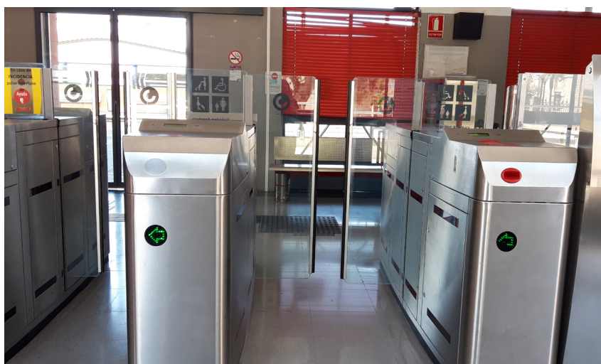
Figura 30: Torn adaptat per a persones amb mobilitat reduïda, més ample que la resta i dotat amb interfon. Imatge pròpia.
