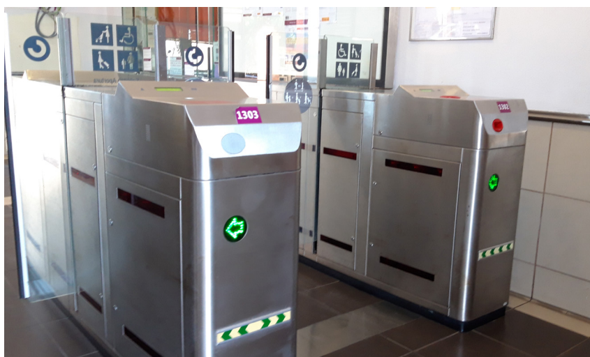
Figura 51: Torn adaptat per a persones amb mobilitat reduïda, més ample que la resta. Imatge pròpia.
