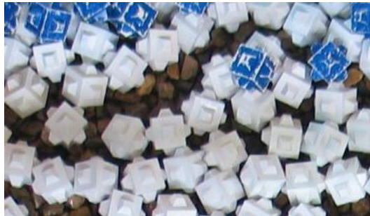
Figura 2.13. Ejemplo de ID de un manto monocapa de Cubípodos.
