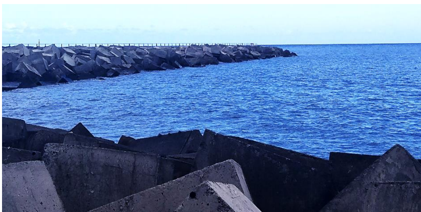
Figura 1.1. Dique en talud de protección costera con manto bicapa de cubos ubicado en zona de rompientes (Santa Cruz de la Palma, Isla de la Palma, Canarias).
