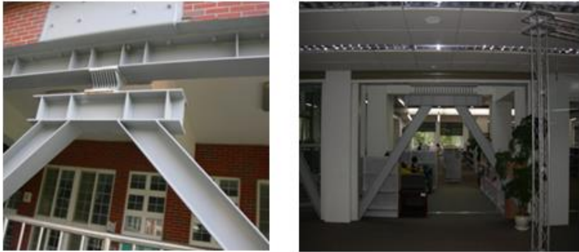
Figura 65: Implementación de amortiguadores histeréticos metálicos en estructuras. Fuente: http://article.sapub.org/10.5923.c.jce.201402.33.html
