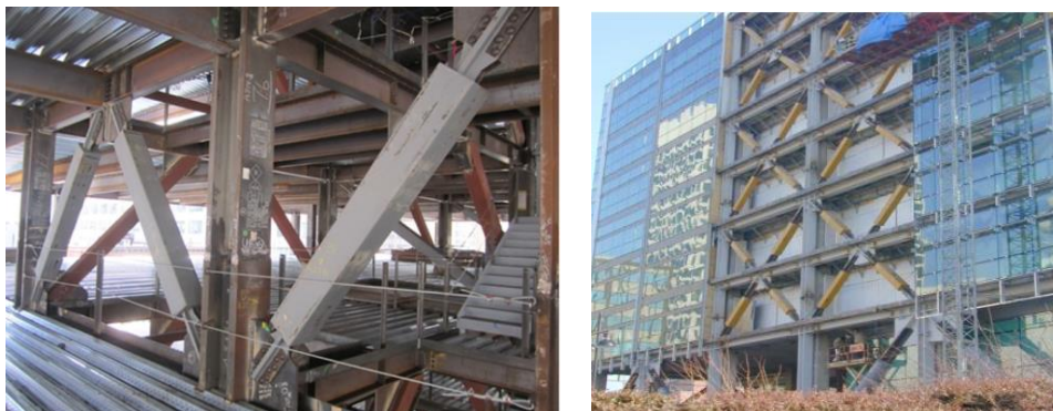
Figura 62: amortiguadores de tipo riostra de pandeo restringido a escala real. Fuente na: Takeuchi, Wada, Matsui, Sitler, Lin, Sutcu, Sakata, Qu, 2017. Fuente nb: Surendran, Varma, 2017.
