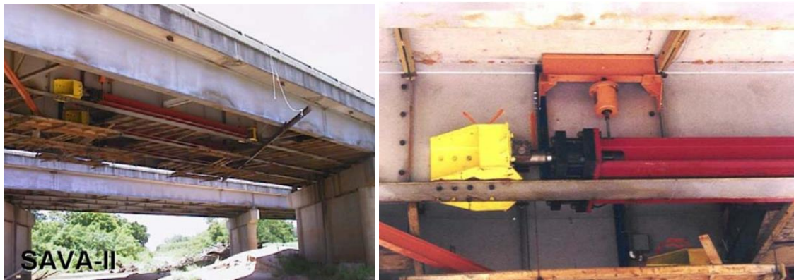
Figura 33a: Primera implementación del amortiguador de orificios variables. Figura 33b: Amortiguador de orificios variables. Fuente 33a y 33b: Spencer, 2002.
