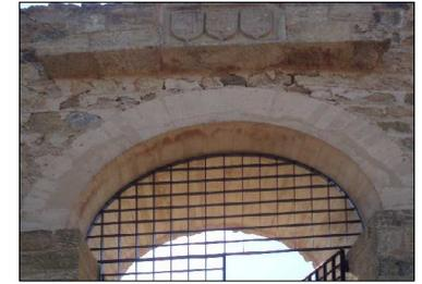
ARCO DE MEDIO PUNTO EJECUTADO CON HORMIGON VISTO MEDIANTE ENCOFRADO. AUN SE PUEDEN VER LAS LINEAS QUE HAN DEJANDO LOS TABLONES DEL ENCOFRADO EN EL INTRADOS DEL ARCO.
