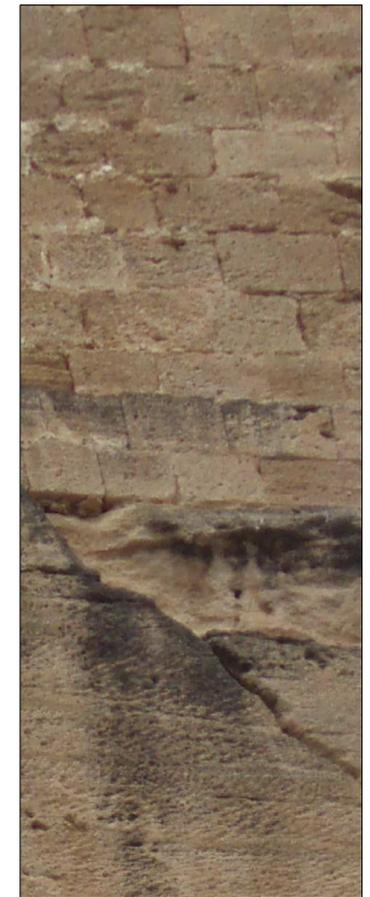
LOS CIMIENTOS DEL CASTILLO ES LA PROPIA ROCA DEL CERRO, EN ELLA SE APOYAN LOS MUROS EJECUTADOS CON MAMPUESTOS DE PIEDRA Y RIPIOS, QUE SIRVE DE MATERIAL DE RELLENO A LOS SILLARES DE PIEDRA .
