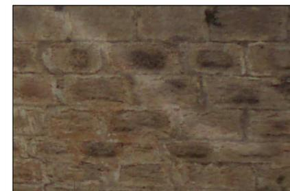
SILLARES DE PIEDRA EN TONOS TIERRA, APAREJADOS A SOGA CON JUNTA DE MORTERO DE CAL DE COLOR MARRON OSCURO, CON UN ESPESOR QUE VA DESDE UN CENTIMETRO A TRES CENTIMETROS.
