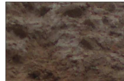
MAMPUESTOS DE PIEDRA MUY EROSIONADOS DE COLOR MARRON OSCURO, CON MORTERO DE CAL DE UN TONO MAS CLARO, COMO MATERIAL DE AGARRE, CUYO ESPESOR VA DE CUATRO CENTOMETROS HASTA 8 CENTIMETROS
