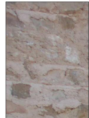
MAMPUESTOS DE PIEDRA EN TONOS TIERRA, SEMEJANTES A LOS SILLARES APAREJADOS A SOGA CON JUNTA DE MORTERO DE CAL DE COLOR MARRON CLARO, CON UN ESPESOR QUE VA DESDE LOS TRES CENTIMETROS HASTA LOS CINCO CENTIMETROS.
