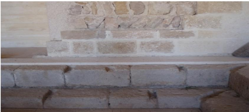
Las cuatro paredes de la sala están encumbradas por medio de arcos ojivales realizados con dovelas de piedra, colocadas a sardinel. Las piezas más oscuras son las encontradas en excavaciones posteriores y colocadas en su lugar por la intervención de dicha sala.
