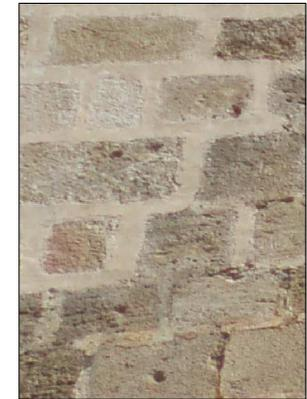
SILLARES DE PIEDRA EN TONOS TIERRA, APAREJADOS A SOGA CON JUNTA DE MORTERO DE CAL DE COLOR MARRON CLARO. CON UN ESPESOR QUE VA DESDE UN CENTIMETRO A TRES CENTIMETROS.
