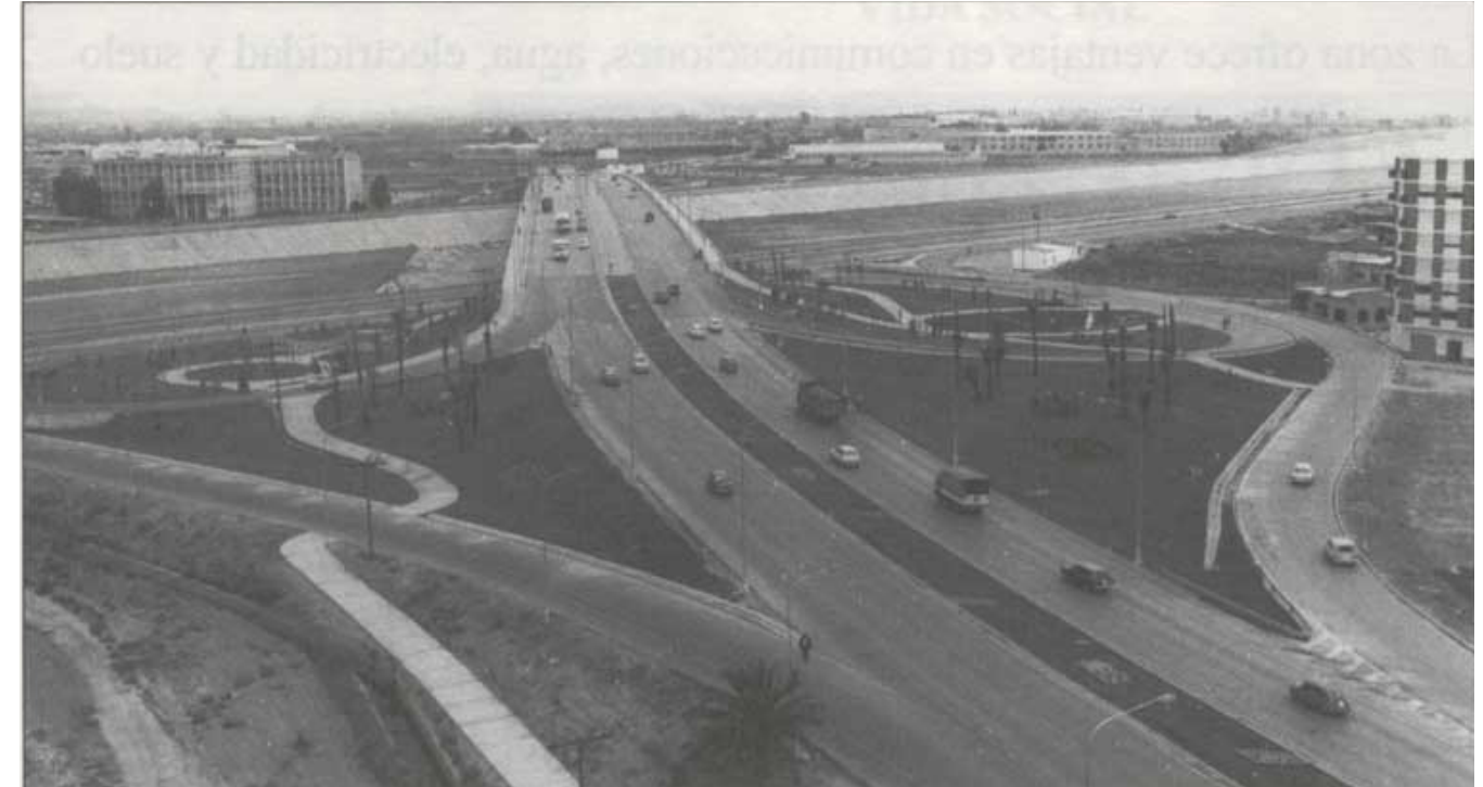
Avenida del Cid a su paso por el nuevo cauce
