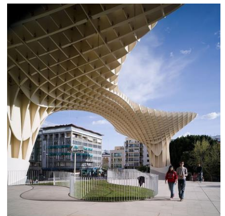
Fig.12, sup: muestra de madera microlaminada Kerto, Emergent timber technologies
