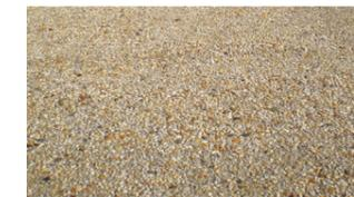
Plaza de acceso: hormigón desactivado, con árido visto 2/3.
