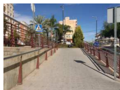
3. Entrada peatonal al recinto de la estación
