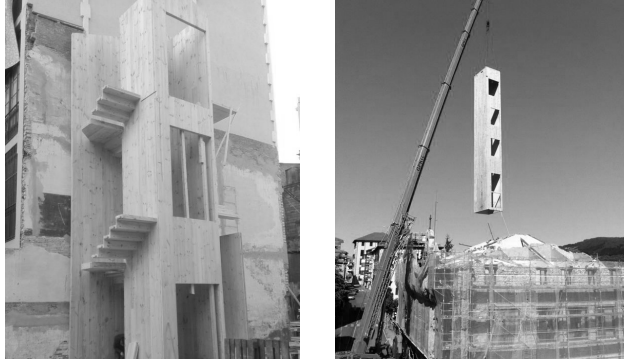
Sistemas de cajas de ascensores prefabricadas de madera laminada, realizadas por la empresa Egoín.
