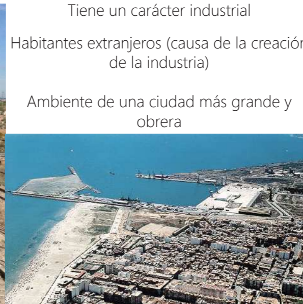
Vista aérea del Puerto de Sagunto
