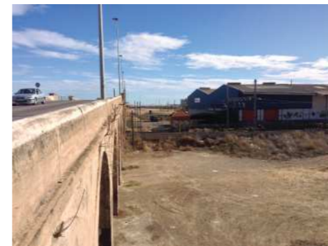
El segundo puente rodado que limita por el norte
