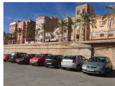
8. Aparcamiento a distinta cota que el nivel de la carretera
