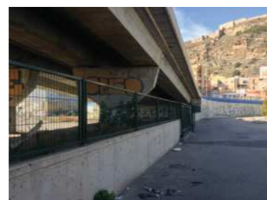
13. Límite del recinto de la estación, el puente que limita por el sur
