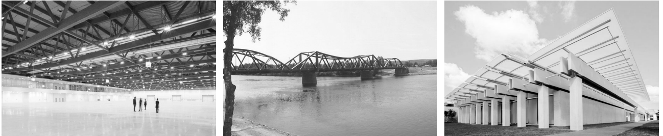
Ejemplos de estructuras de gran canto construídas en madera laminada. A la izquierda, el Pabellón de la Feria de Vicenza (Italia); en el centro, el puente Flisa en Noruega y por último, el Pabellón para el Museo Kimbell de Renzo Piano.
