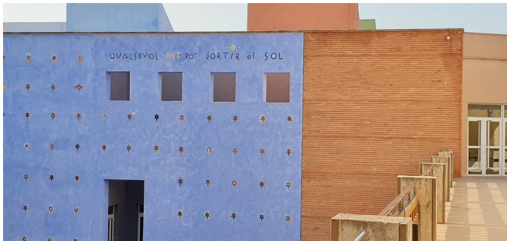
Figura 4: Fachada aulario del Campus de Gandia
