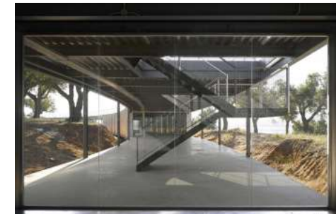
Imagen V.29 Contacto del edificio con el terreno
