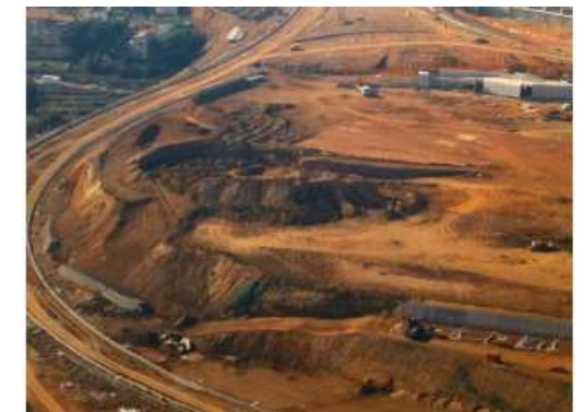
Imagen IV.29 Excavación Complejo Tiro con Arco
