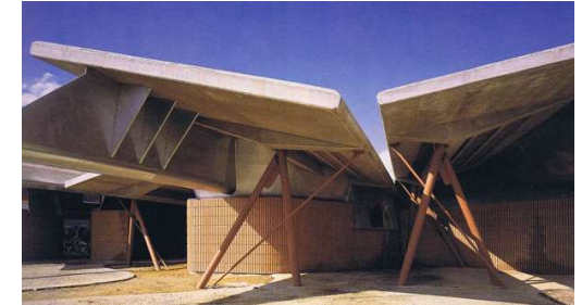
Imagen IV.27 Bloque edificio de entrenamiento
