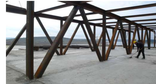
Imagen V.13 Fase de construcción. Cerchas de 3 m de canto
