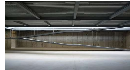
Imagen V.14 Acceso a sala interior de remo
