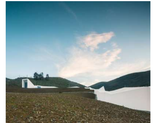
Imagen V.40 Vista exterior zona social al fondo
