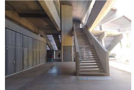
Imagen V.67 Acceso a zona indoor
