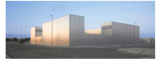
Imagen V.16 Fábrica de montaje eléctrico. Don Benito, Badajoz. 2014-2016
