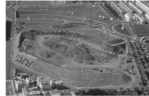
Imagen V.59 Proceso de construcción, Movimiento de tierras
