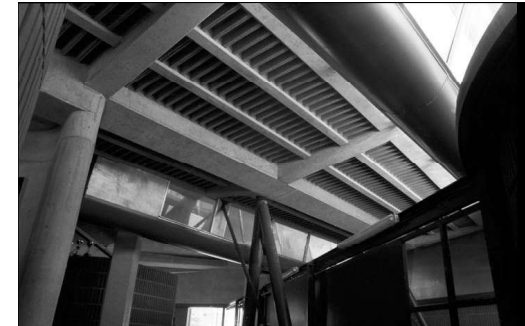
Imagen IV.30 Interior edificio de entrenamiento
