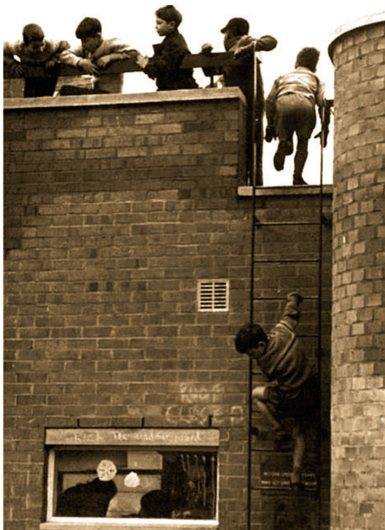
[ Figura 71. ] Niños trepando a la cubierta por la escalera modificada.
