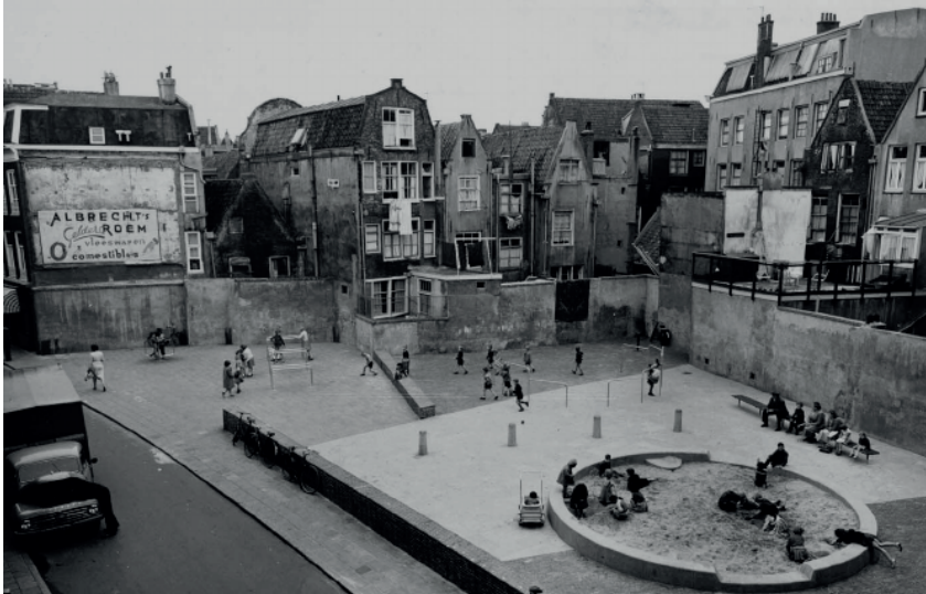
[ Figura 78. ] Solar y posterior Playground en Zeedijk por Aldo van Eyck.
