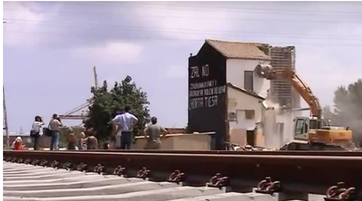
Fig. 36. Derribo en La Punta.
