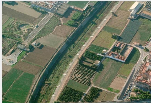
Tras las obras de revestimiento del cauce del Carraxet, este ha recuperado en buena medida la vegetación propia y con ello numerosas especies vuelven a utilizar este espacio, convirtiéndolo en un corredor ecológico de gran interés
