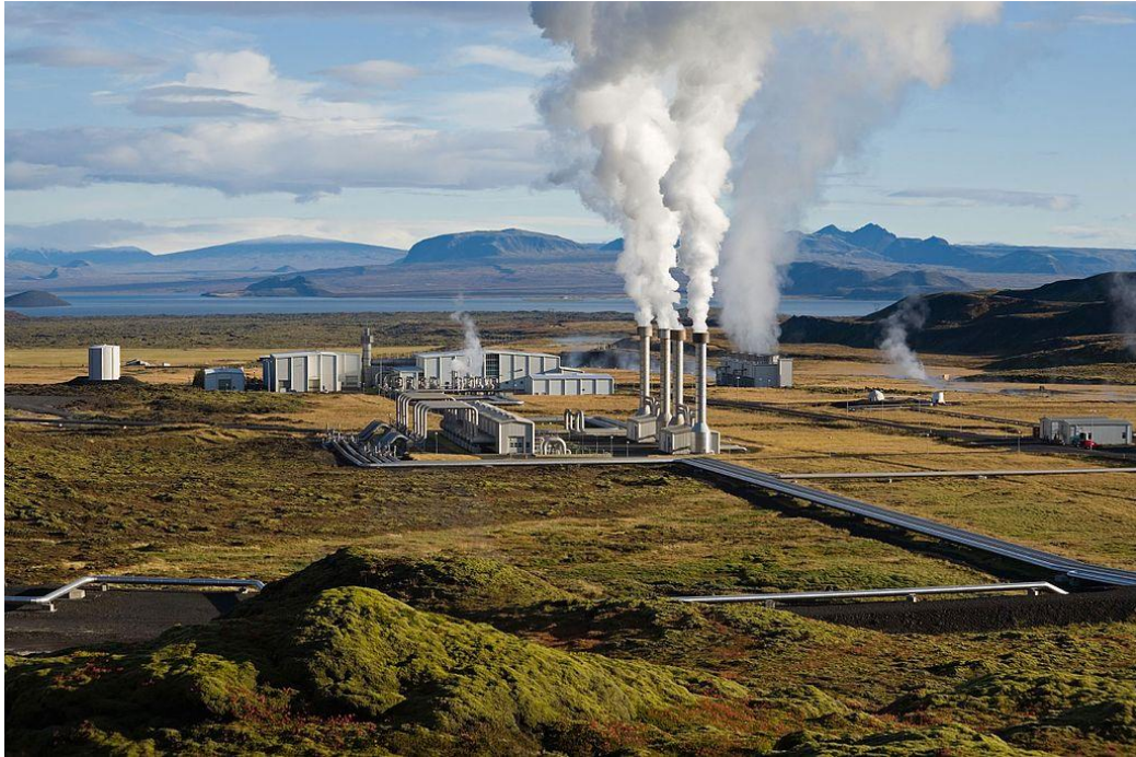
FIG 2. Planta geotérmica de Nesjavellir en Islandia.
