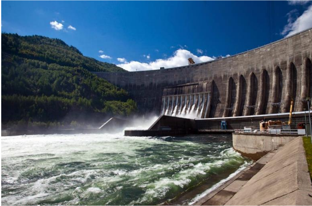
FIG 3. Central hidroeléctrica de Sayano-Shushenskaya, Rusia.
