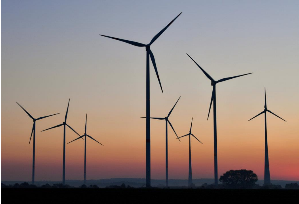
FIG 1. Turbinas de viento cerca de Jacobsdorf, Alemania
