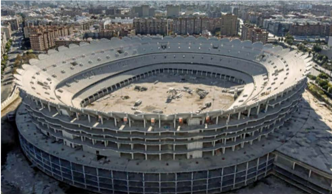
Estructura del nuevo estadio del Valencia en la avenida de las Cortes de Valencia. / BIEL ALIÑO
