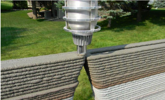
Figuras 13 y 14. Impresión del hormigón. Fuente: https://cutt.ly/MMkqlg
