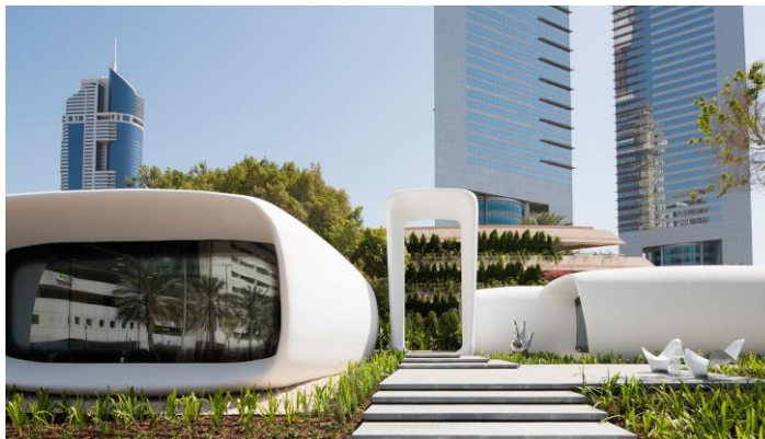
Figura 15. Oficinas en Dubai construidas por WinSun. Fuente: http://cort.as/-M58Y
