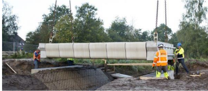
Figura 53. Puente ciclista en Holanda. Fuente: http://cort.as/-M7Hq
