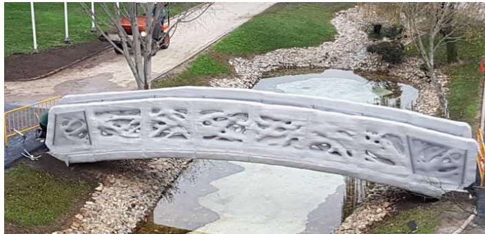
Figura 54. Puente en Alcobendas del IAAC. Fuente: http://cort.as/-M7Hq
