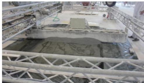
Figura 40. Nivelado de la capa. Fuente: http://cort.as/-MBIf
