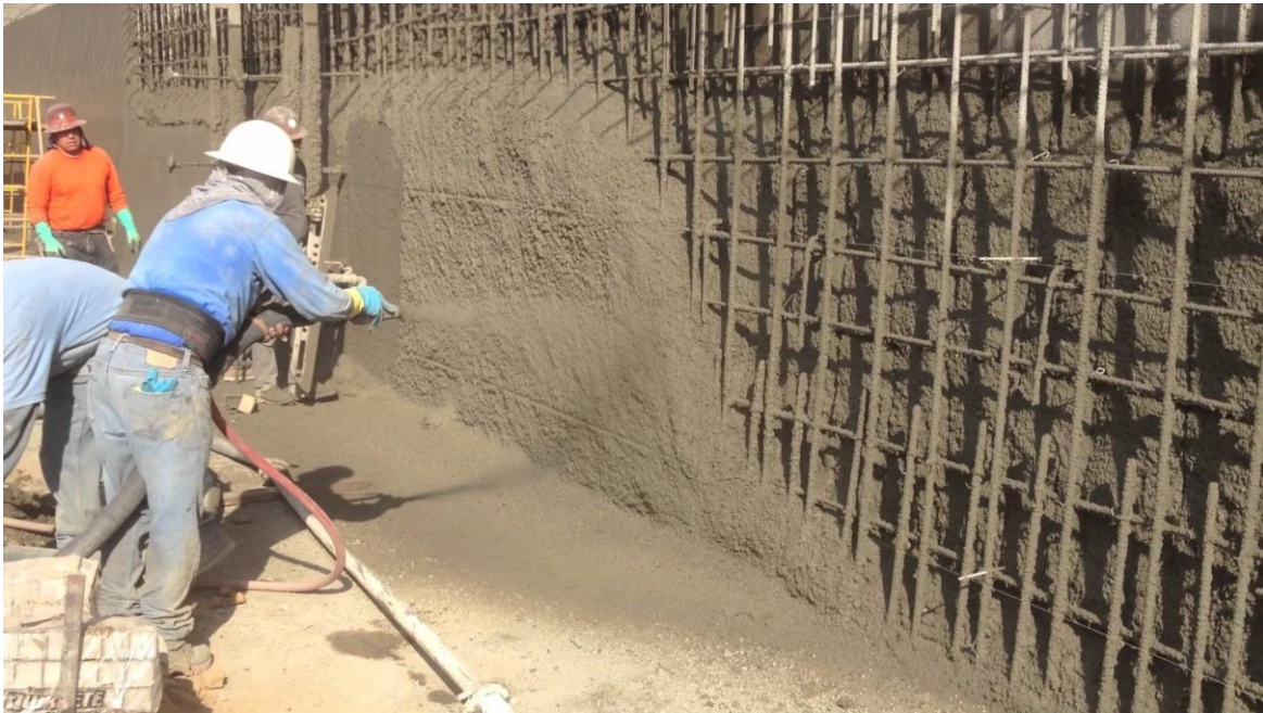
Figura 3. Proyección de hormigón en una obra. Fuente: https://bit.ly/2LOazGS
