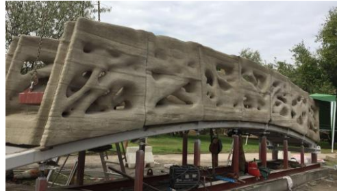
Figura 42 Ensamblaje de diversas piezas. Fuente: http://cort.as/-MBIf
