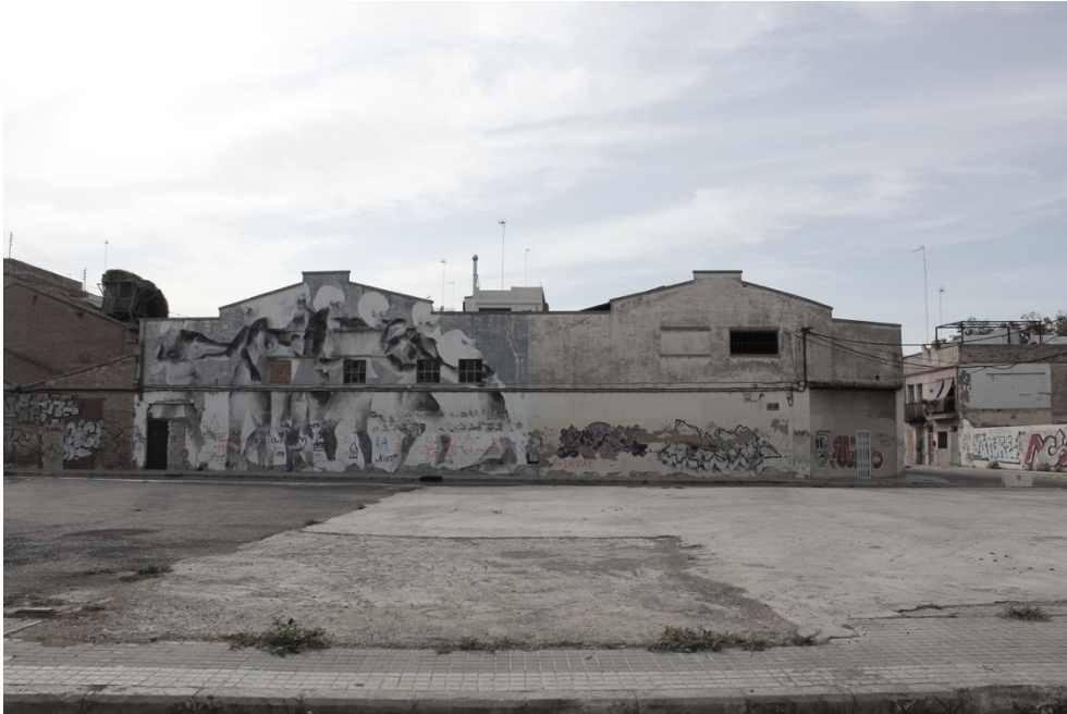
Fig. 52. Alzado actual de la nave junto con el solar exento que presenta en la parte frontal
