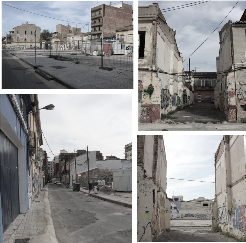
Fig. 60. Vistas desde el solar frente a la nave industrial
