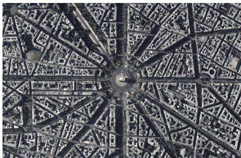
Fig. 4. Vista en planta de París, mostrando la organización de las avenidas que conectan la ciudad y parten del Arco de Triunfo.
