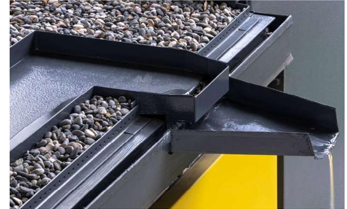
Imagen 93 Canalón de la bajante del módulo central.
