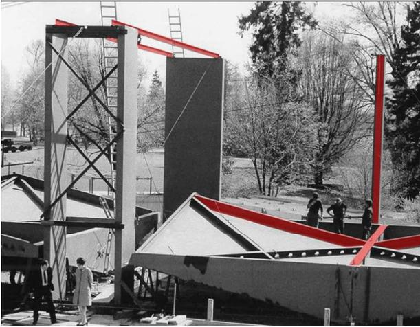
Imagen 63. Construcción: Primera fase del montaje de la cubierta.
