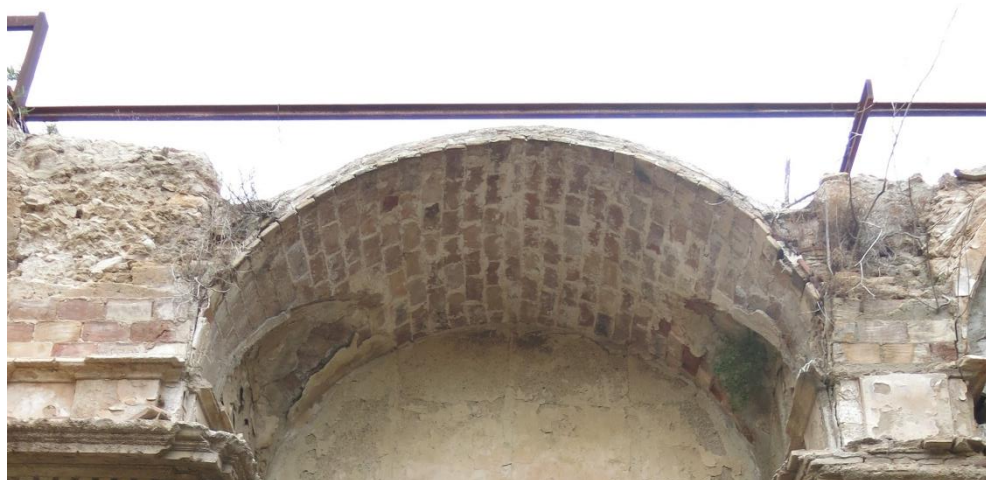
Fig. 55: Bóveda de cañón con lunetos en la Iglesia de San Juan, fotografía propia
