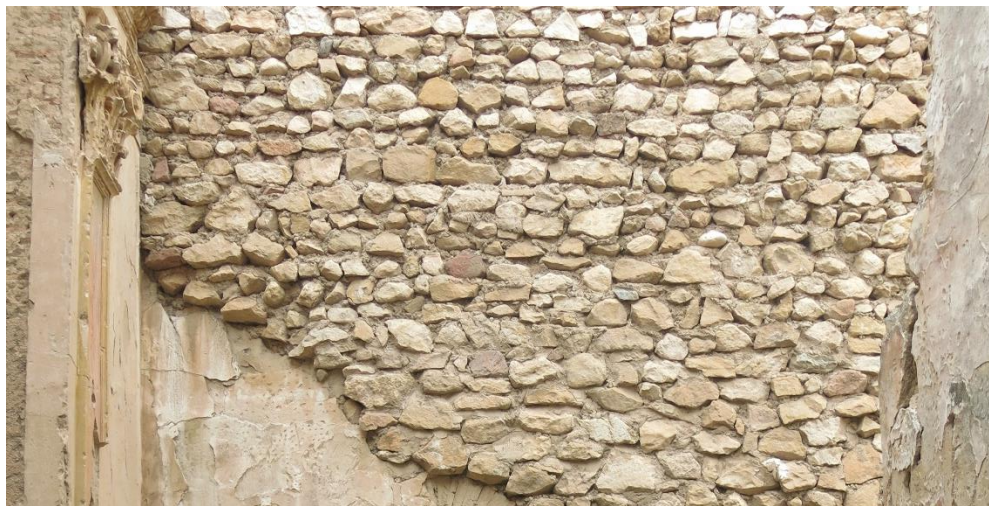
Fig. 52: Muro de mampostería interior, fotografía propia
