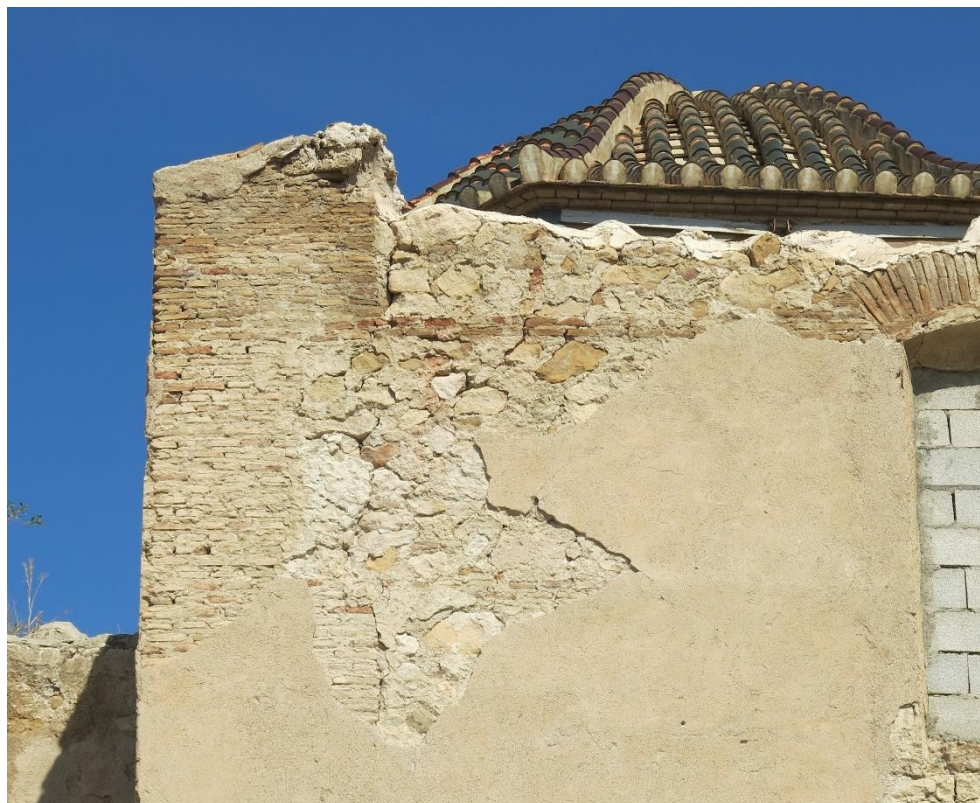
Fig. 54: Detalle del muro de mampostería con verdugadas cerámicas, fotografía propia.
