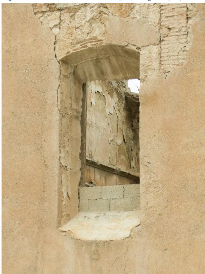
Fig. 58: Detalle arco tabicado múltiple, fotografía propia
