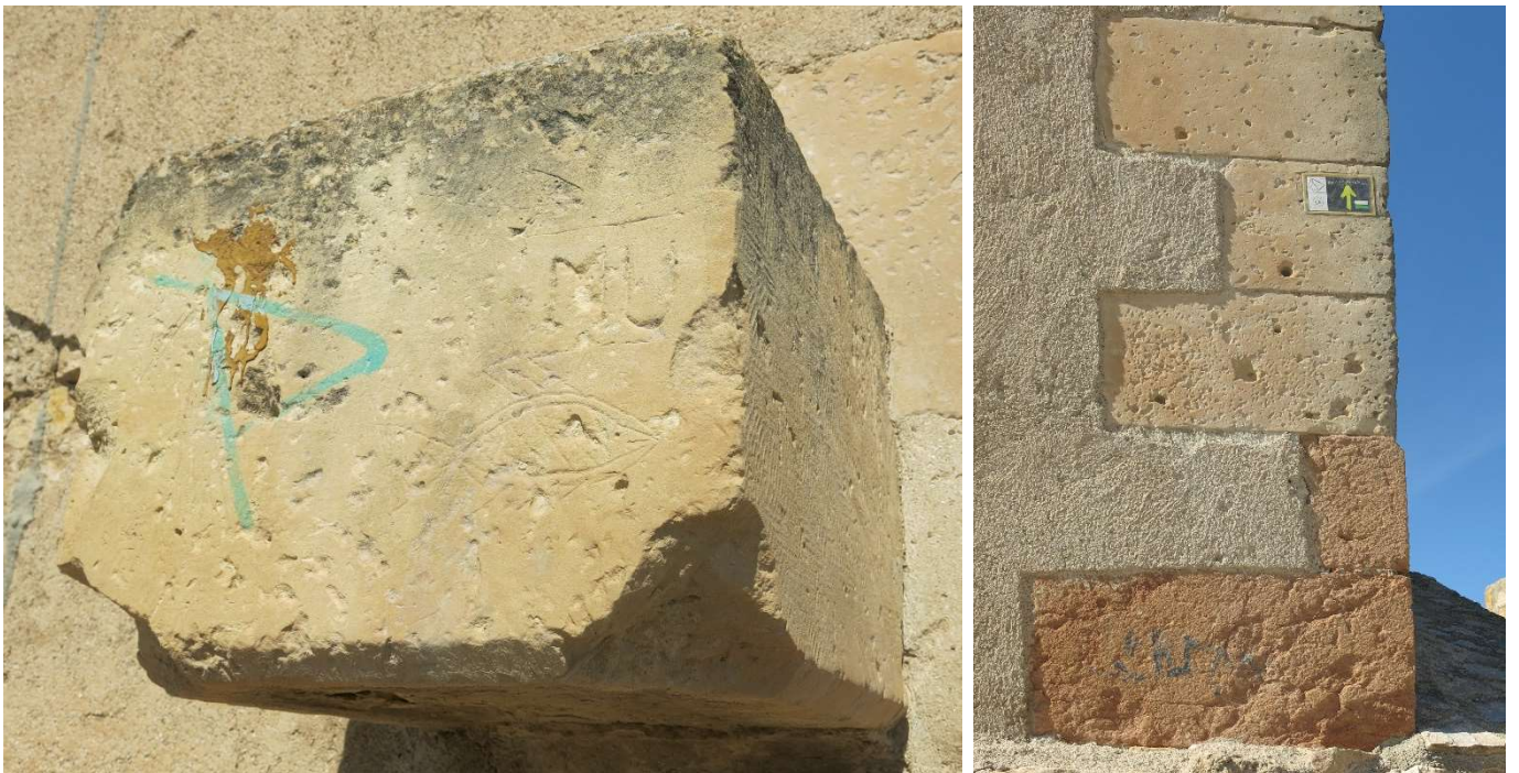
Fig. 61 y 62: Detalles de la sillería de la Iglesia de San Juan, Fotografías propias
