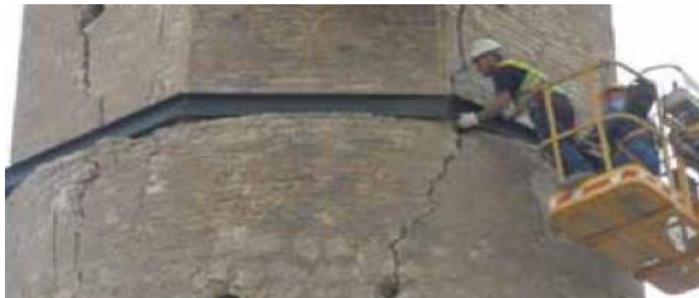
Fig. 44: Ejecución del zunchado de la torre (Prefasi, Sánchez, González)
