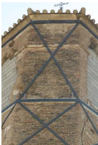
Fig. 51: Torre de la Iglesia de San Juan, fotografía propia
