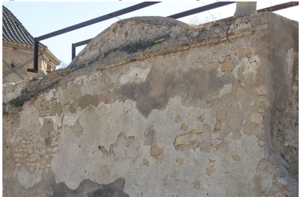
Fig. 65: Detalle del enlucido en la Iglesia de San Juan, fotografía propia
