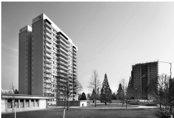
FIG. 8: Buggi 50. Photo: Johannes Vogt, Mannheim / Sto AG, Stühlingen
