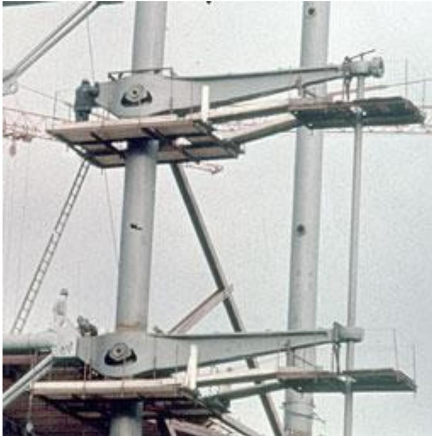
Ilustración 53 Proceso constructivo – fijación de los tirantes
