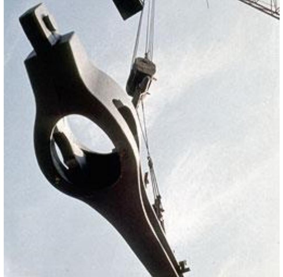
Ilustración 52 Proceso constructivo – colocación de las Gerberettes sobre los pilares
