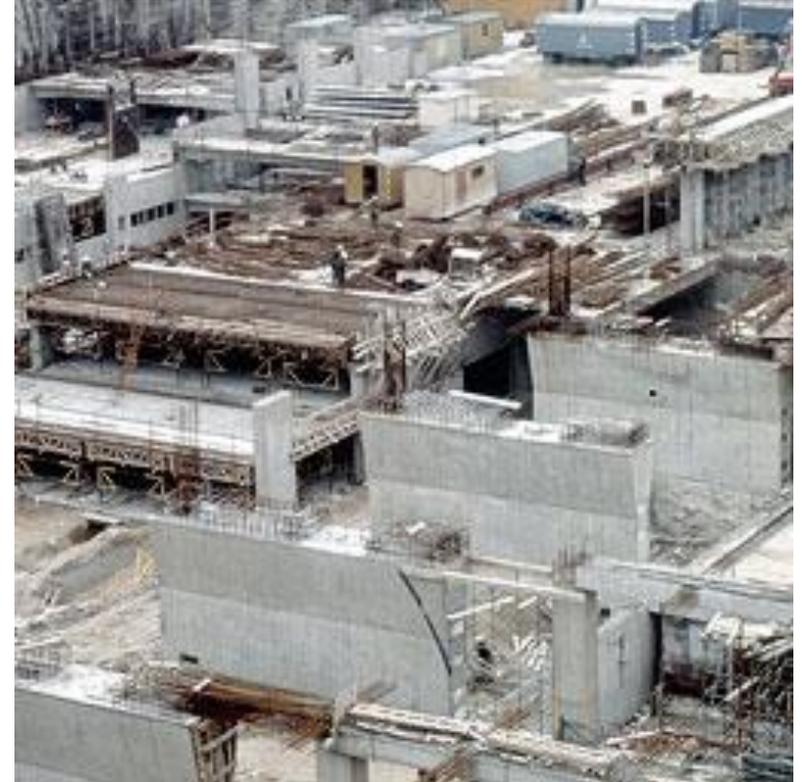
Ilustración 50 Proceso constructivo – muros de sótano de hormigón
