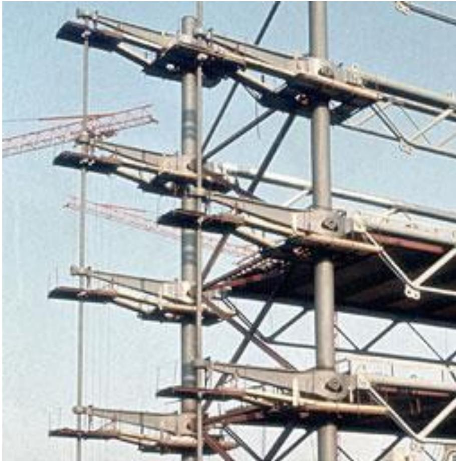
Ilustración 55 Proceso constructivo – Colocación del forjado.
