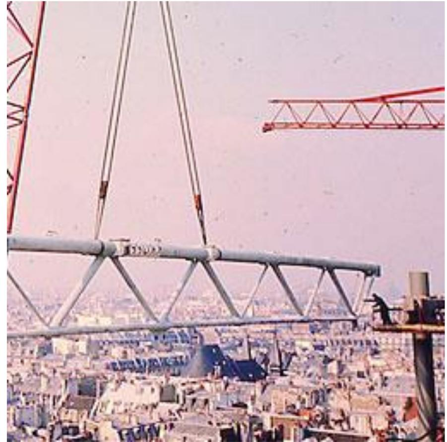
Ilustración 54 Proceso constructivo – apoyo de la viga Warren sobre las Gerberettes.
