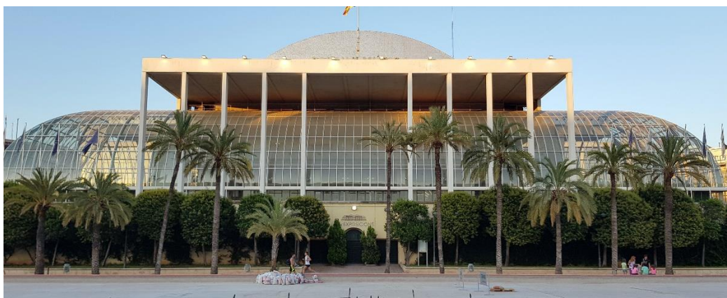
Fig. 6 Imagen fachada principal suroeste. Bóveda vidriada (Elaboración propia)
