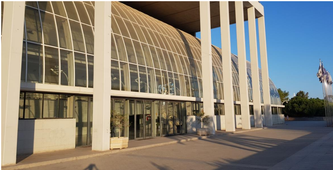
Fig. 48 Pórtico en la fachada principal el 29 Julio a las 20:00 horas (Elaboración propia)
