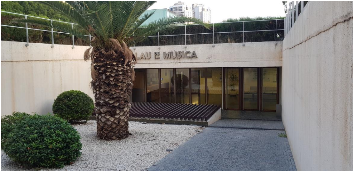
Fig. 15 Acceso a la ampliación (Elaboración propia)
