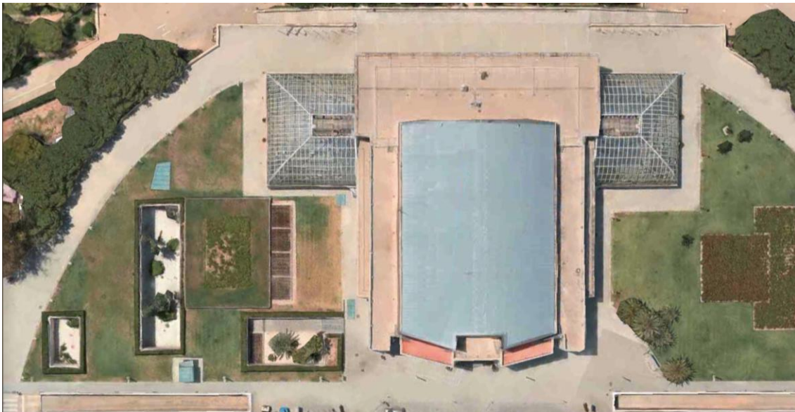
Fig. 13 Vista aérea de la ampliación
