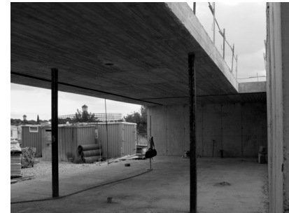
Fig.42. Casa del Atrio en ejecución. Espacio diáfano. Fotografía: Estudio FSA [Fuente: Estructuras Singulares | UPV]
