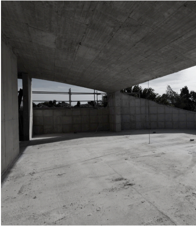
Fig. 101. Ventana cuarto de baño superior. [Fuente: Estudio FSA]
