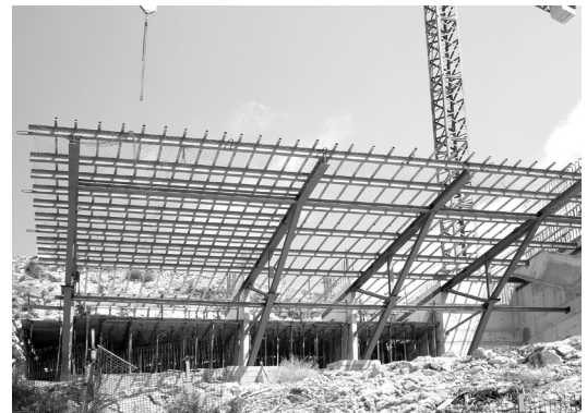
Fig. 77. Cimbra metálica. Fotógrafo: Estudio FSA [Fuente: Estructuras Singulares I UPV]
