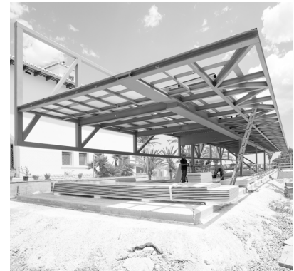
Fig.123. Estructura celosía metálica. Fotógrafo: Gemma Aparicio. [Fuente: Estructuras Singulares I UPV]
