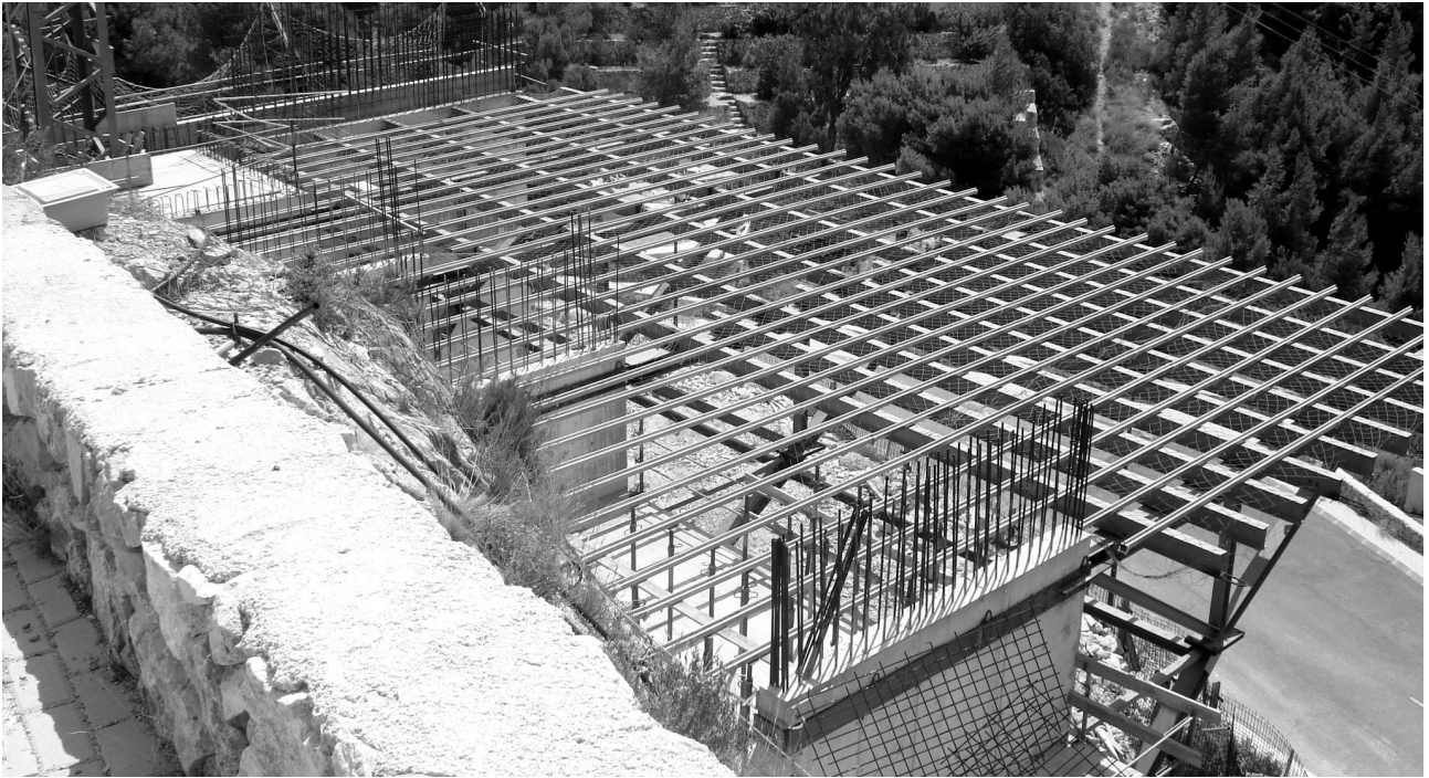
Fig. 76. Cimbra metálica sujeta a las pantallas de hormigón. Fotógrafo: Estudio FSA [Fuente: Estructuras Singulares I UPV]
