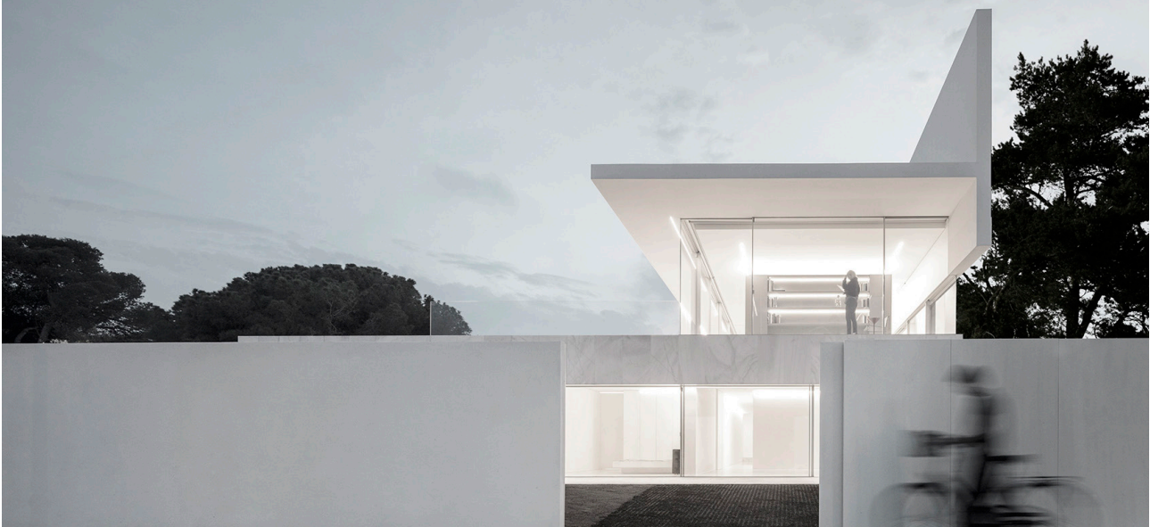
Fig. 110. Vista exterior casa Hofmann. Fotógrafo: Fernando Guerra [Fuente: Estudio FSA]
