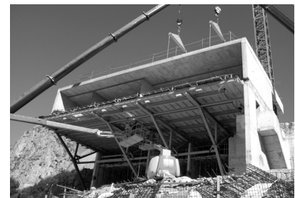
Fig. 66. Casa del Acantilado en ejecución. Cimbrado. Fotografía: Estudio FSA [Fuente: Estructuras Singulares I UPV]
