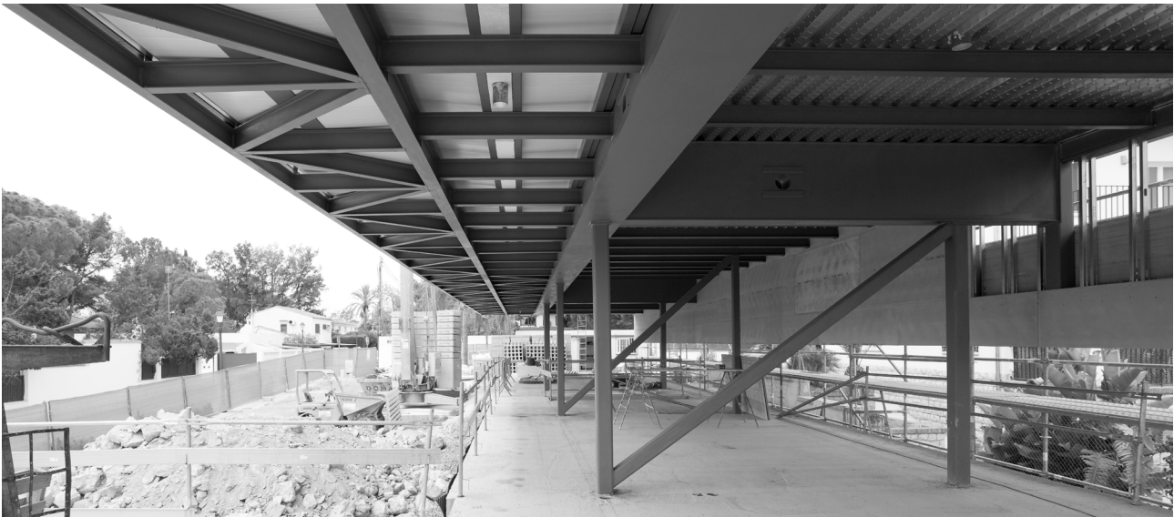
Fig. 127. Pórticos estructurales. Fotógrafo: Gemma Aparicio. [Fuente: Estructuras Singulares I UPV]
