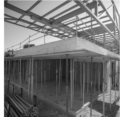
Fig. 126. Estructura celosía y sótrano. Fotógrafo: Gemma Aparicio. [Fuente: Estructuras Singulares I UPV]
