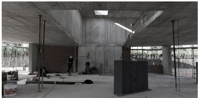
Fig. 95. Espacio de doble altura en ejecución. Fotógrafo: Estudio FSA. [Fuente: Estructuras Singulares I UPV]
