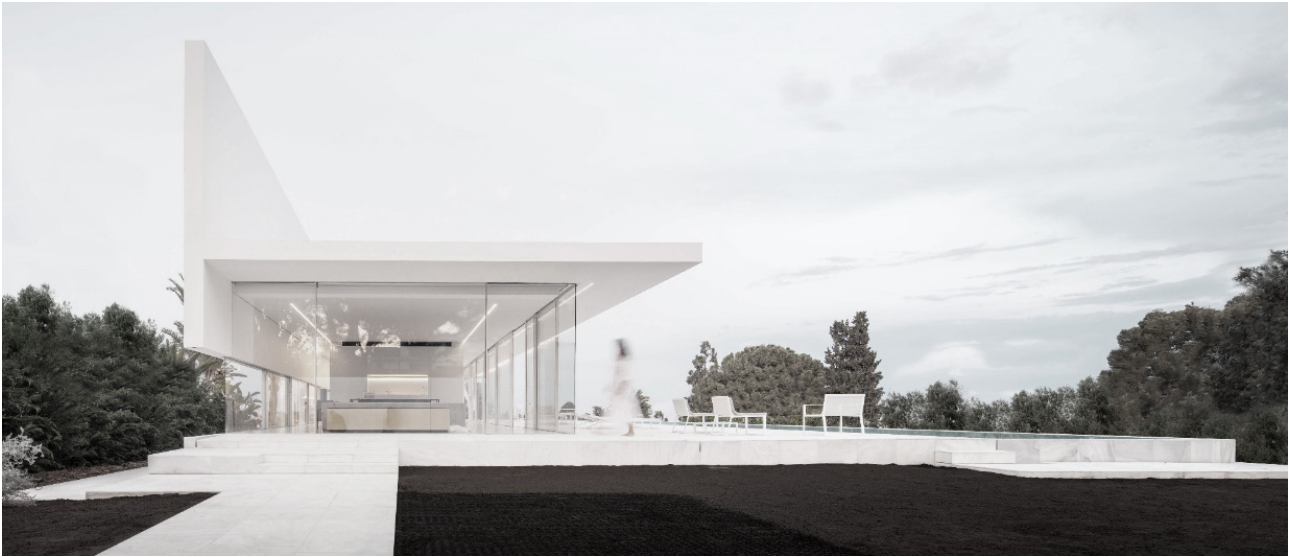
Fig. 120. Vista exterior casa Hofmann. Fotógrafo: Fernando Guerra [Fuente: Estudio FSA]
