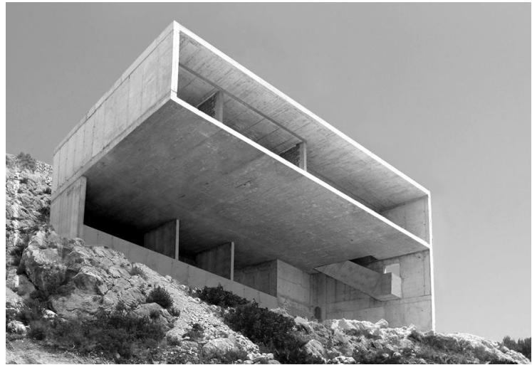
Fig. 68. Fotos de la ejecución. Pescante y pantallas. Fotógrafo: Estudio FSA [Fuente: Estructuras Singulares I UPV]
