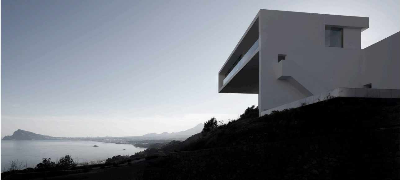
Fig. 49. Vista del entorno de la casa del Acantilado. Fotografo: Diego Opazo [Estudio FSA]
