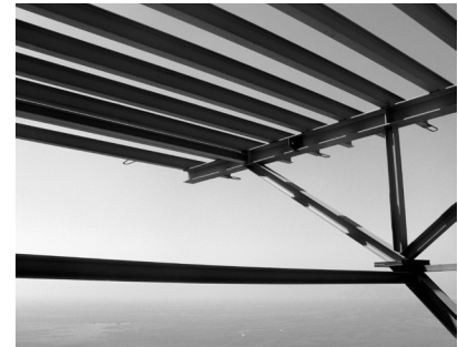
Fig. 78. Nudo articulado de la cimbra. Fotógrafo: Estudio FSA [Fuente: Estructuras Singulares I UPV]
