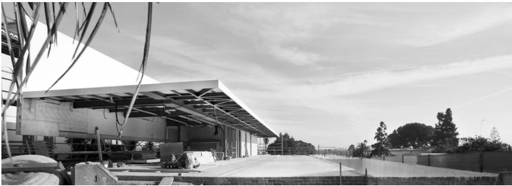
Fig. 129. Revestimiento de la estructura metálica. Fotógrafo: Gemma Aparicio. [Fuente: Estructuras Singulares I UPV]
