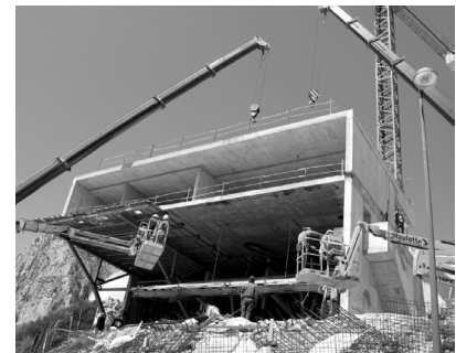
Fig. 80. Descimbrado. Fotógrafo: Estudio FSA [Fuente: Estructuras Singulares I UPV]
