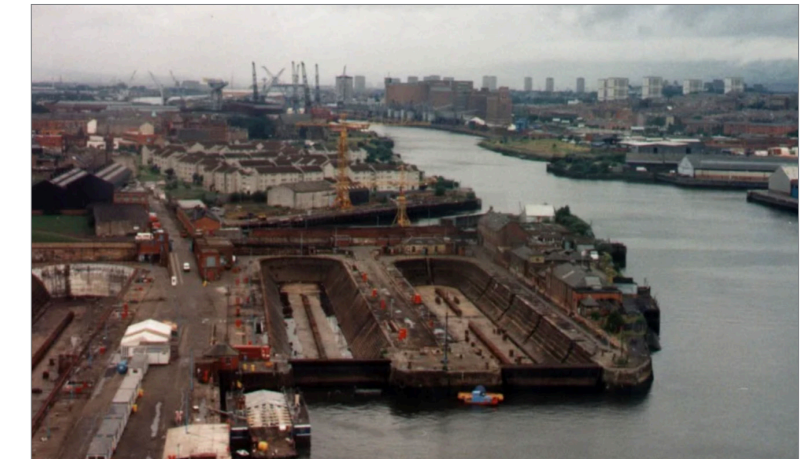
Figura 7: Fotografía Govan Graving Docks, River Clyde ciudad de Glasgow, UK. en el año 1980. ( https://www.reddit.com/r/drydockporn/comments/33b53z/govan_graving_docks_river_clyde_glasgow_scotland ).
