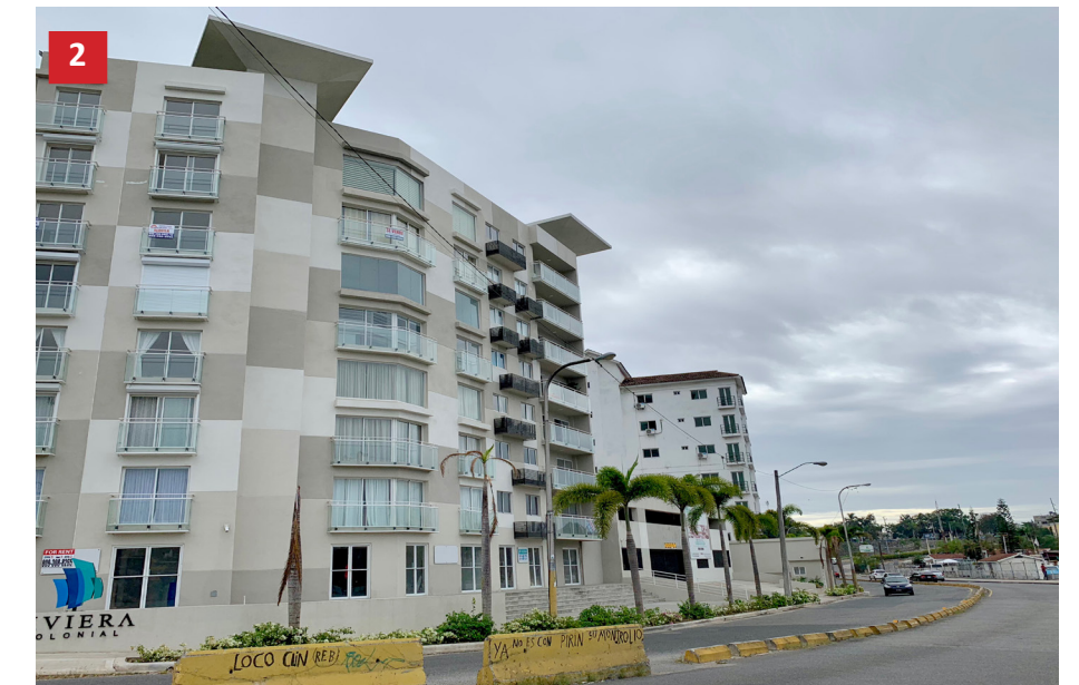
Figura 138. Fotografía Proyecto Residencial Riviera Colonial, Sto. Dgo. 2019 (Elaboración propia).
