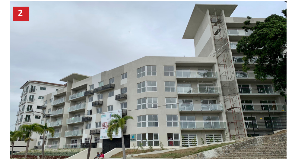
Figura 137. Fotografía Proyecto Residencial Riviera Colonial, Sto. Dgo. 2019 (Elaboración propia).
