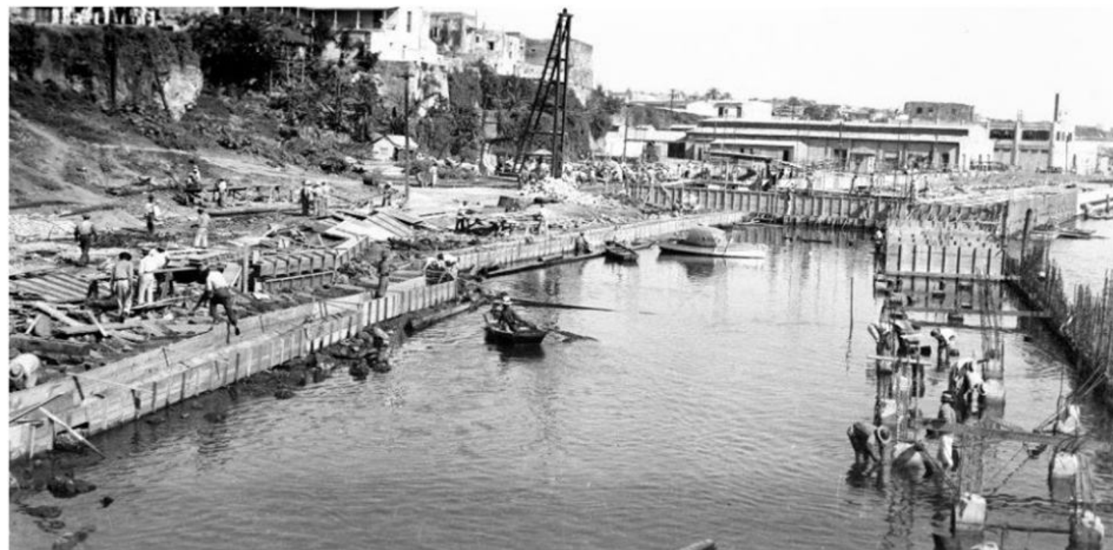
Figura 60: Fotografía de la construcción del Puerto de Santo Domingo durante la dictadura de Trujillo año 1937 (Imágenes de archivo periódico Listín Diario de Santo Domingo)
