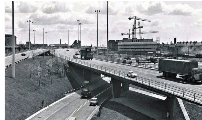
Figura 6: Fotografía M8 Townhead Interchange ciudad de Glasgow, UK. en el año 1970 ( https://www.bbc.com/news/uk-scotland-glasgow-west-46544755 ).
