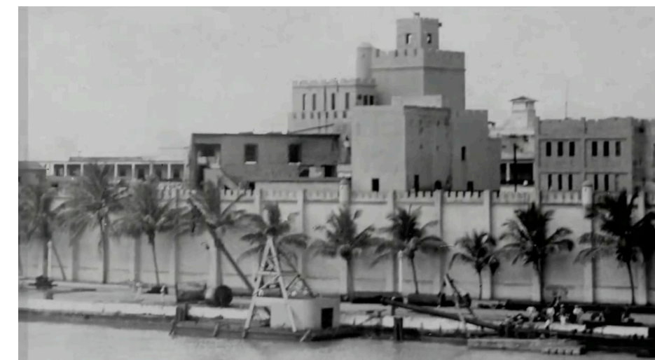
Figura 62: Fotografía de la construcción de la Muralla de Trujillo año 1940 (Imágenes de archivo periódico Listín Diario de Santo Domingo).
