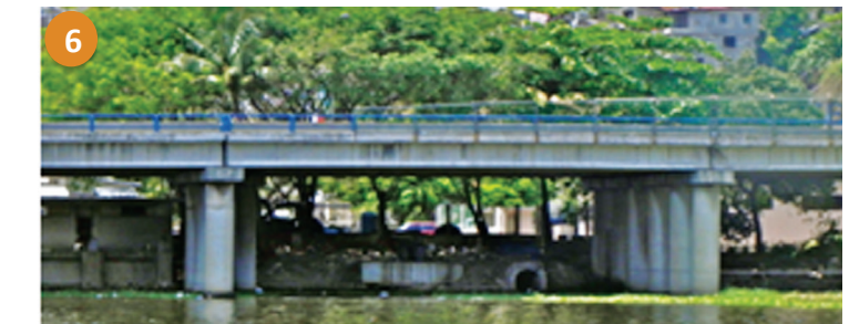
Bajo la Ave. del Puerto se observan las bocas de las alcantarillas de aguas negras que desembocan en el Ozama.
