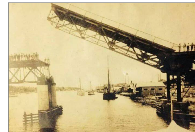
Figura 148: Fotografía puente levadizo Radamés Trujillo , construido sobre el puente de Ulises Heureaux que fue destruido por el ciclón San Zenón, en la Ciudad de Santo Domingo año 1955 (Boletín del Archivo General de la Nación, Fotos de Santo Domingo).
