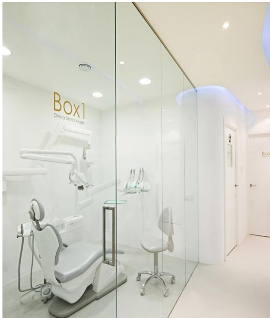
Figura 66: Clínica dental con Paneles PDLC ensamblados en fabrica 5+5mm - Estado transparente.
