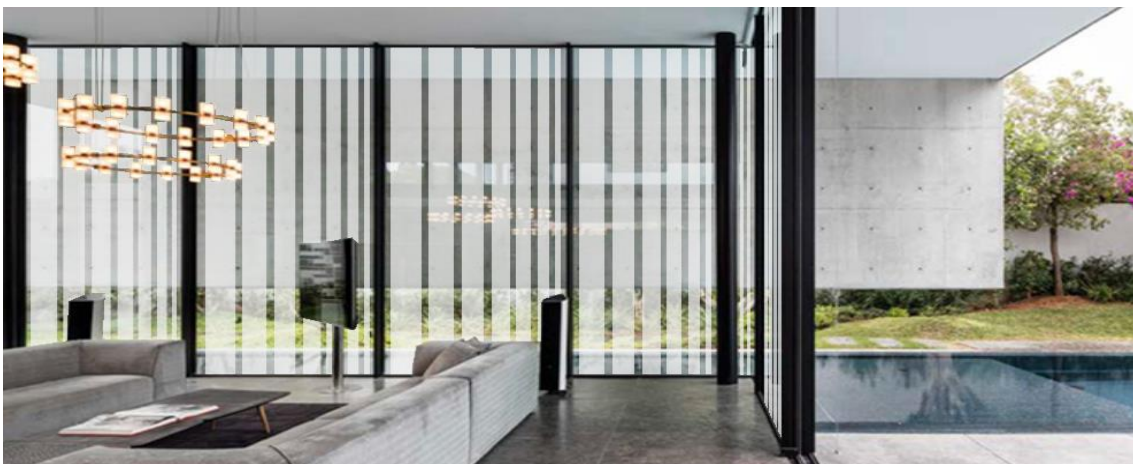
Figura 27: Vivienda unifamiliar con Paneles PDLC adheridos a vidrio en el interior de cámara de aire, estado opaco.
