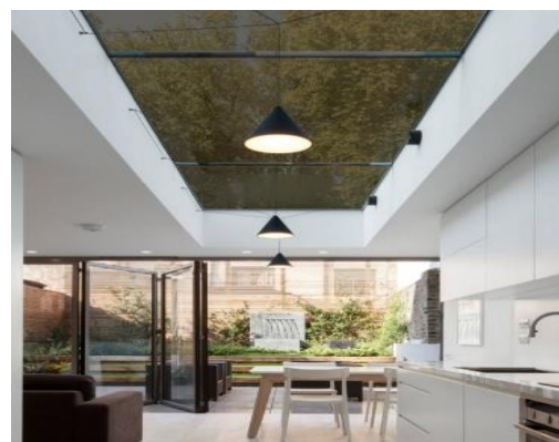
Figura 53: Panel PDLC adherido a tragaluz efecto polarizado – Estado opaco
