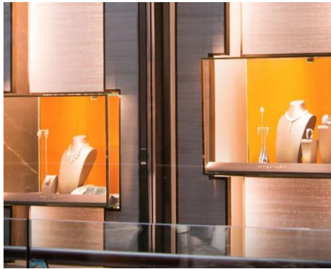
Figura 56: Escaparate joyería con panel PDLC adherido cara interior vidrio seguridad - Estado transparente
