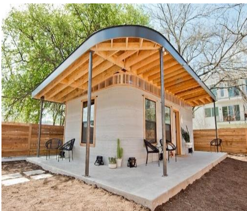
Figura 1: Casa de hormigón impresa en 3D.
