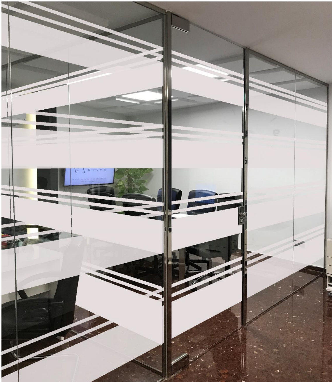
Figura 90: Propuesta de paneles PDLC adheridos a cara interior de vidrio templado, diseño: franjas horizontales. Sala de reuniones estudio de arquitectura Grupo Value – Estado opaco.
