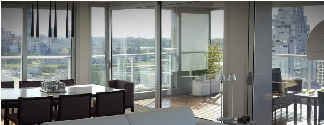
Figura 50: Vivienda con Paneles PDLC adheridos a vidrio en el interior de cámara de aire - Estado transparente.
