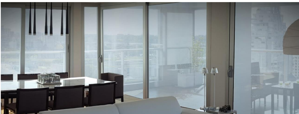
Figura 51: Vivienda con Paneles PDLC adheridos a vidrio en el interior de cámara de aire - Estado opaco.
