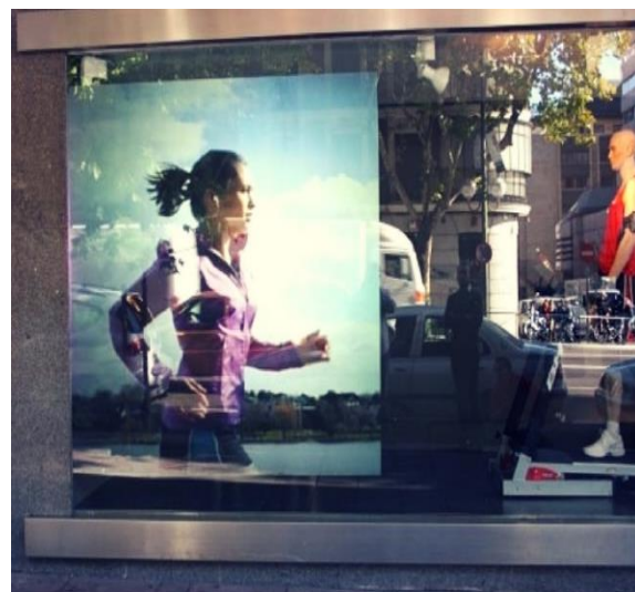
Figura 19: Ejemplo de panel PDLC adherido a vidrio existente con retroproyección
