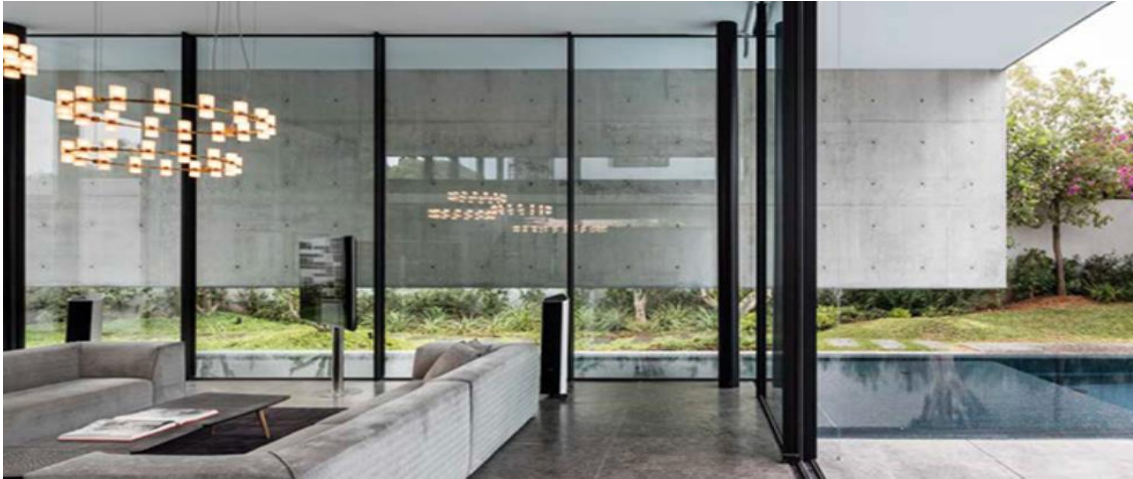
Figura 26: Vivienda unifamiliar con Paneles PDLC adheridos a vidrio en el interior de cámara de aire, estado transparente.
