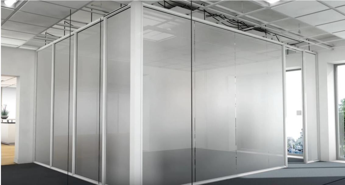
Figura 37: Puesta en obra del panel PDLC ensamblado en fabrica – Paso 8.
