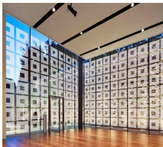
Figura 69: Museo con Paneles PDLC ensamblados en fabrica - Estado opaco.
