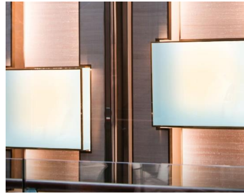
Figura 57: Escaparate joyería con panel PDLC adherido cara interior vidrio seguridad - Estado opaco
