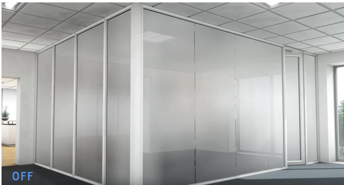
Figura 40: Puesta en obra del panel PDLC ensamblado en fabrica – Acabado final: Estado opaco.
