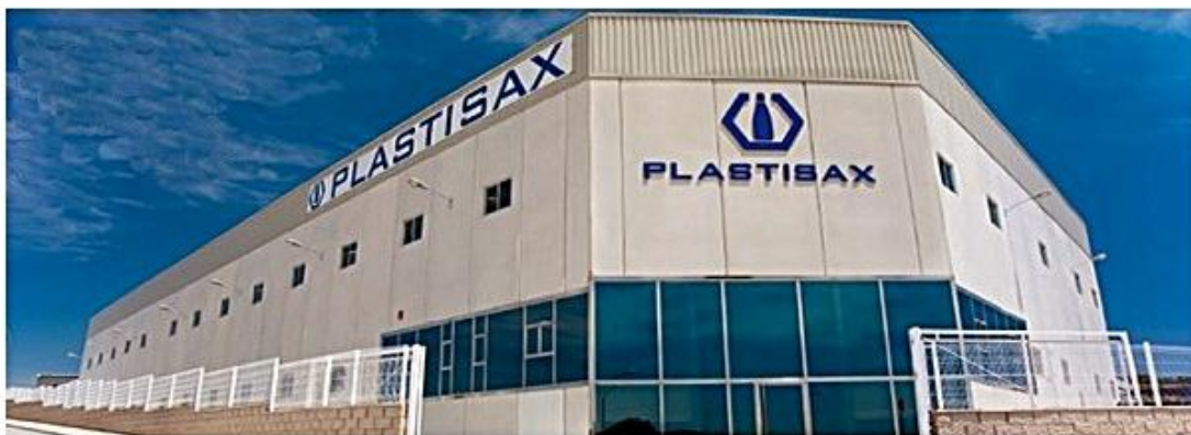
Figura 3. Fachadas exteriores del edificio de estudio
