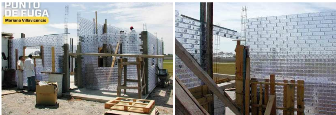
Gráfico 36blocks de construcción a base de botellas de plástico FUENTE: http://media.metroscubicos.com/625x415/media/2012/10/24/vivienda-plastico.jpg FECHA: 2018/05/29
