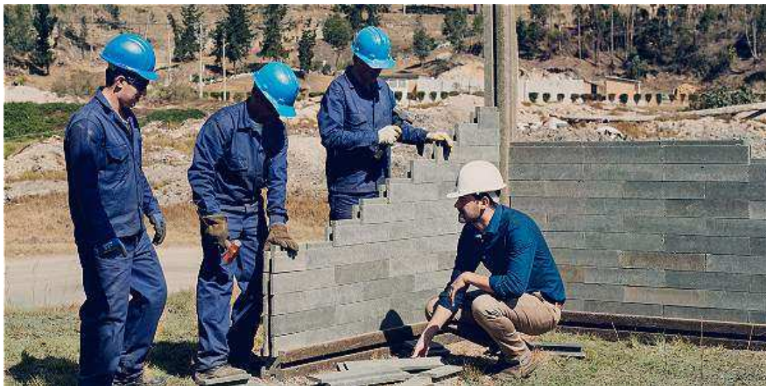
Gráfico 34 Construcción de una casa con ladrillos PET Colombia FUENTE: http://www.eltiempo.com/contenido/estilo-de-vida/ciencia/IMAGEN/IMAGEN-16582136-2.jpg FECHA: 2018/05/19
