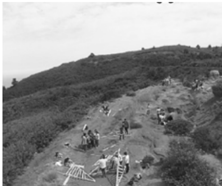
F9. Workshop construcción miradores en Q.V
