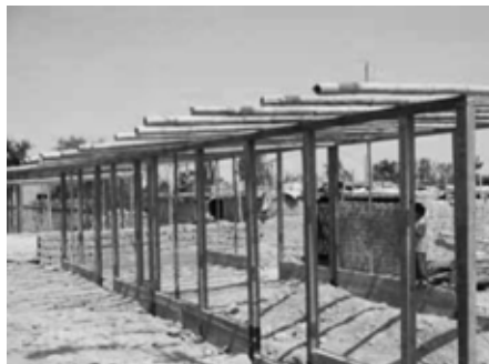
F31. Montaje de estructura
