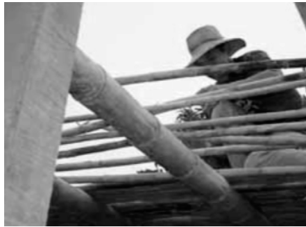
F31. Montaje cubierta
