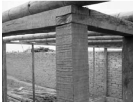
F30. Detalle encuentro entre vigas
