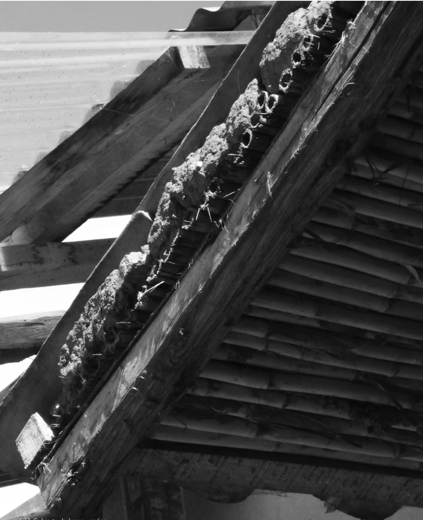
F27. Cubierta de barro y cañas.
