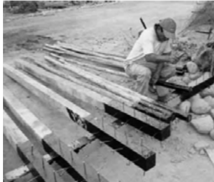
F29. Pilares pintados con pintura asfáltica
