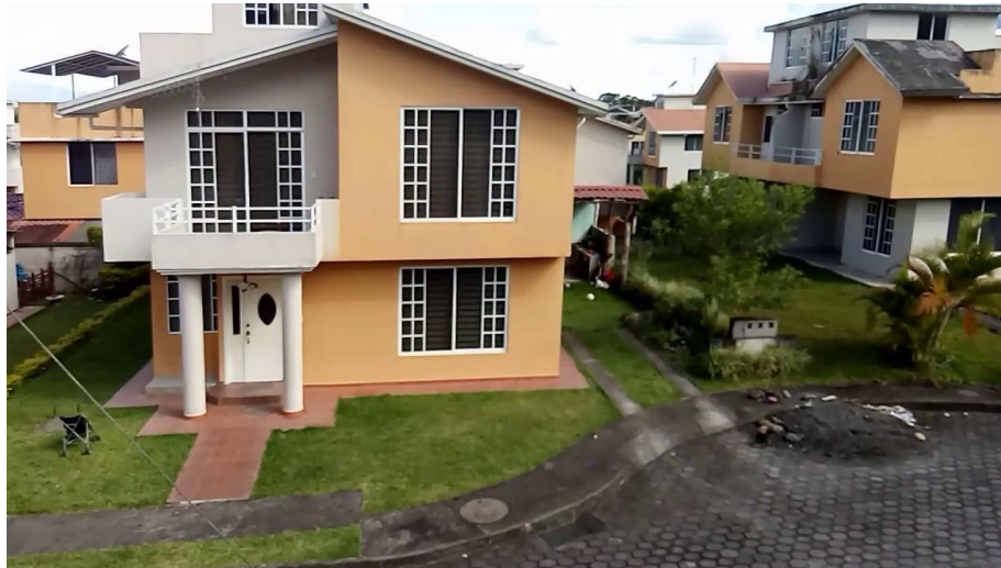
Imagen 15 Vivienda de cemento en ciudadela privada convencional en Macas Fuente: Google Earth
