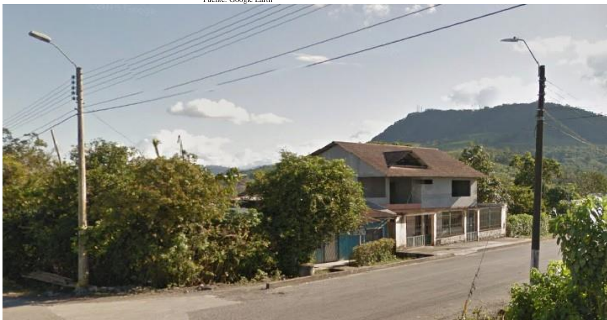
Imagen 27 Vista lateral de fachada Caso 2 vivienda convencional Fuente: Google Earth
