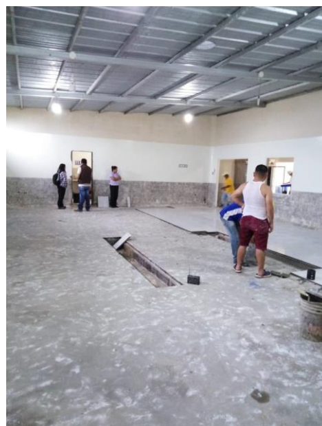
Imagen 9 Instalación de piso de cerámica de fábrica de quesos en Macas Fuente: https://twitter.com/vicentesmacas
