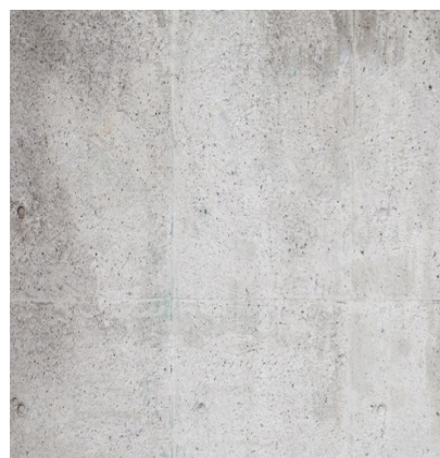
Acabado hormigón visto
