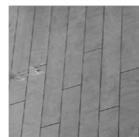
Acabado de cerramientos
